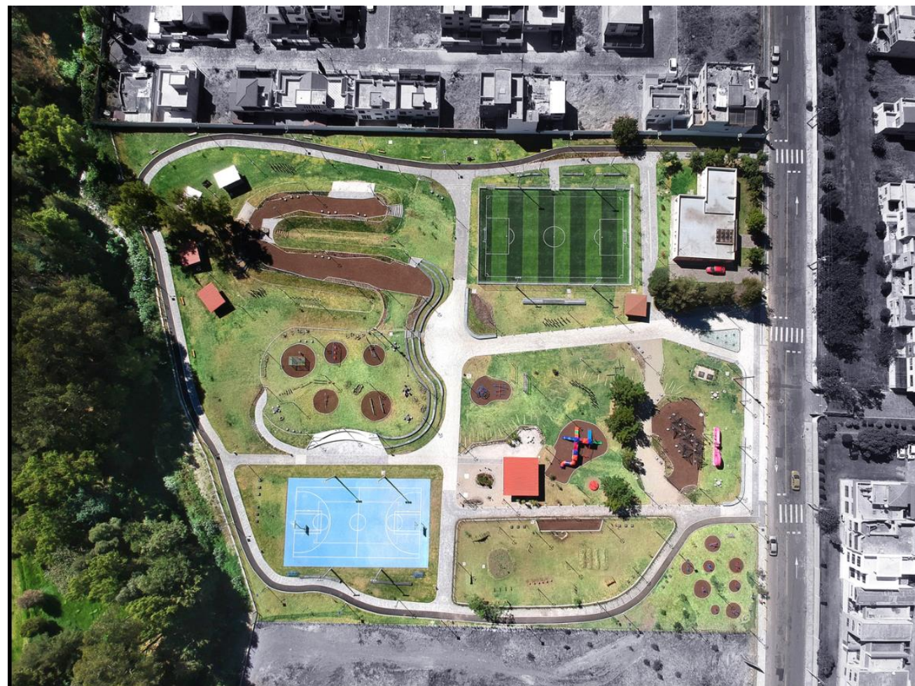
Gráfico 57. Parque 6 de junio- Vista Aérea. Fuente: Plataforma arquitectura 2018.
