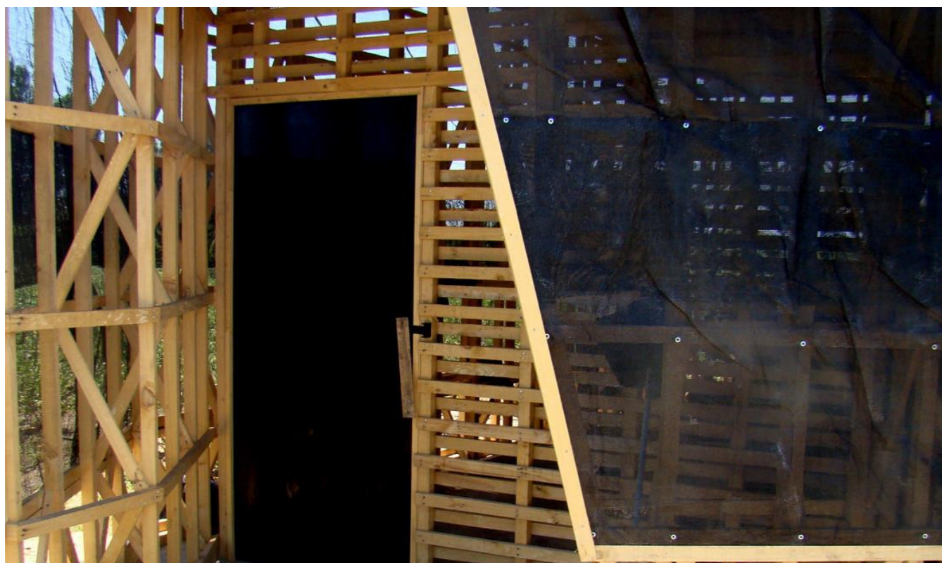
Figura 51: Armado estructural e ingreso Fuente: https://www.plataformaarquitectura
