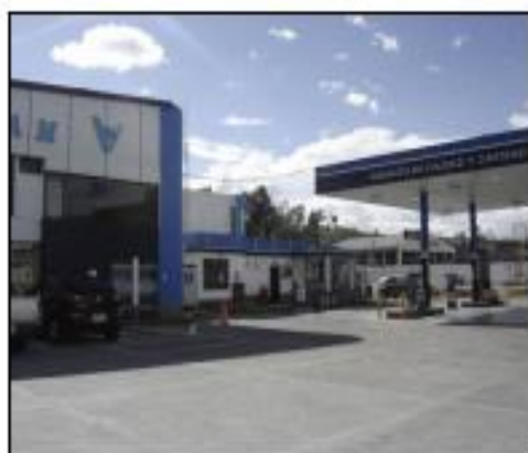
Foto 3. Vista de los espacios e instalaciones presentes en la Estación de Servicio
