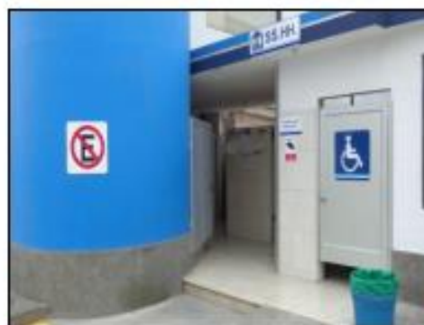
Foto 44. Primer plano del área de baños
