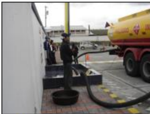
Foto 31. Supervisor pendiente del proceso de llenado de los tanques
