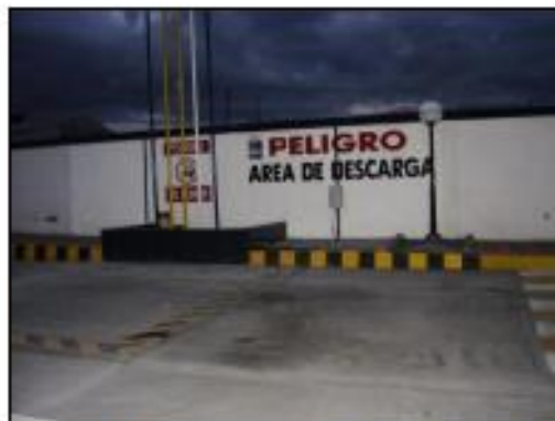
Foto 26. Señalización de seguridad en el área de descarga de combustibles
