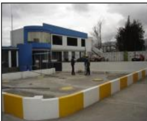
Foto 11. Pararrayo junto al área de almacenamiento y ubicado en la terraza de la casa azul (parte superior izquierda de la foto)
