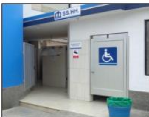
Foto 53. Vista general del área de baños. Destaca el acceso a baños de discapacitados
