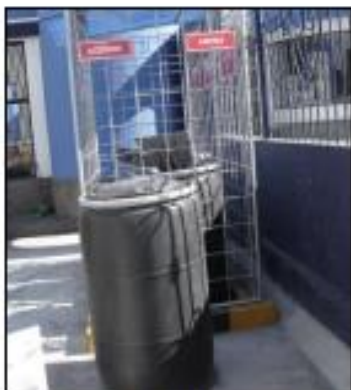
Foto 13. Tanque de 50 galones con arena
