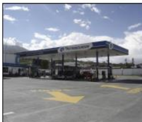
Foto 58. La marquesina está equipada con bajantes de agua lluvia
