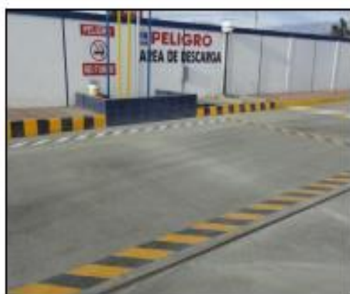
Foto 59. Vista de las canaletas perimetrales en área de descarga
