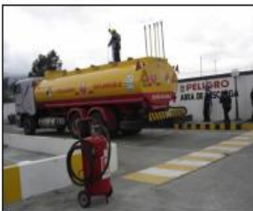
Foto 12. Extintor portátil ubicado junto al área de descarga y almacenamiento
