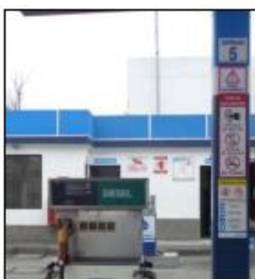
Foto 33. Medidas de seguridad implementadas y ubicadas en las columnas de la marquesina
