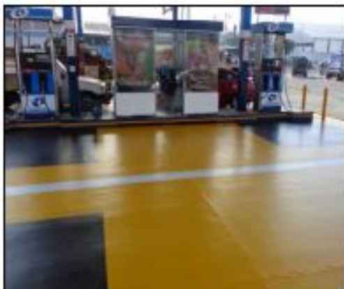
Foto 55. El piso de la estación de servicio está pavimentado al igual que el área de despacho y almacenamiento de combustibles.
