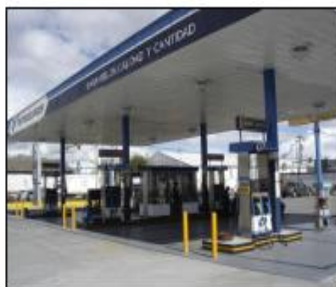
Foto 2. Isla principal de despacho
