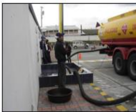
Foto 16. Supervisor pendiente del proceso de llenado de los tanques
