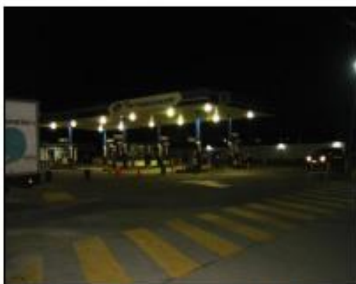
Foto 51. Iluminación nocturna de la Estación de Servicio
