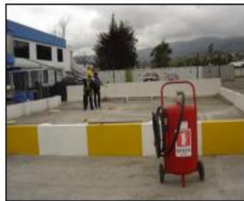
Foto 64. Vista del cubeto en área de tanques
