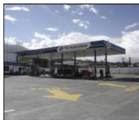
Foto 6. Primer plano de la Isla de Despacho de la Estación de Servicio Vigesam
