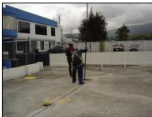
Foto 32. Control manual del nivel de los tanques de almacenamiento de combustibles
