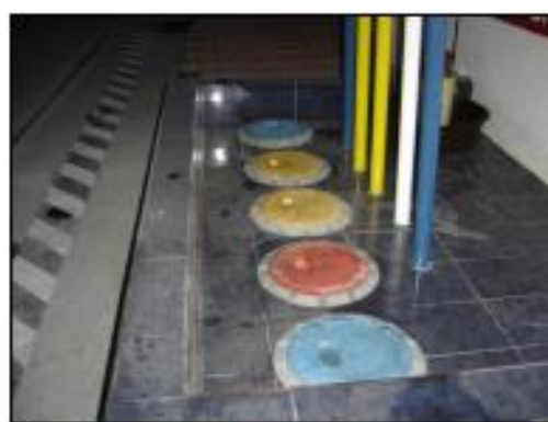
Foto 30. Vista general de manholes en el área de descarga de combustibles
