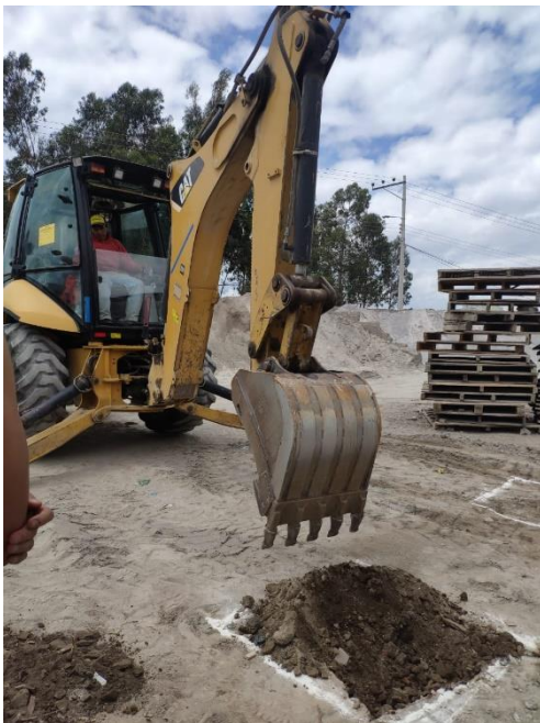
Ilustración 8.9. Excavación de Zanja para Ensayo Geogauge.
