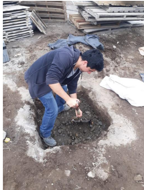
Ilustración 8.12. Colocación de capas de zanja.
