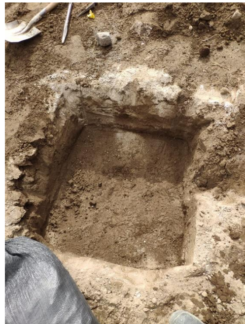
Ilustración 8.10. Compactación de Zanja para Ensayo Geogauge.
