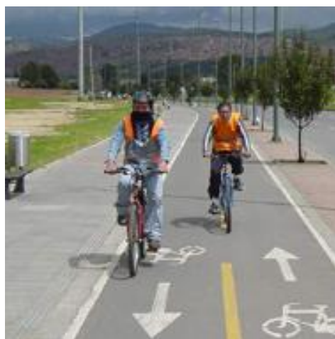
Ilustración 5: Ciclovía de segregación dura. Obtenida de Cicloruta en Bogotá, Enrique Peñalosa.
