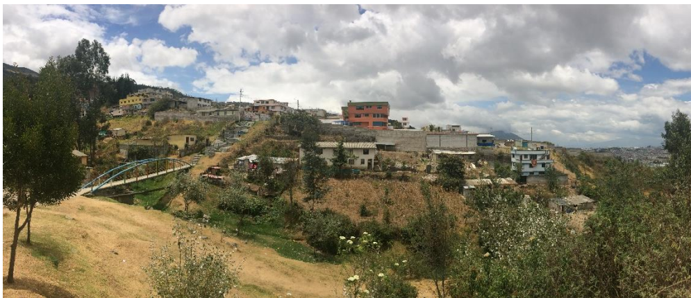
Fotografía 15: Puente de conexión barrial
