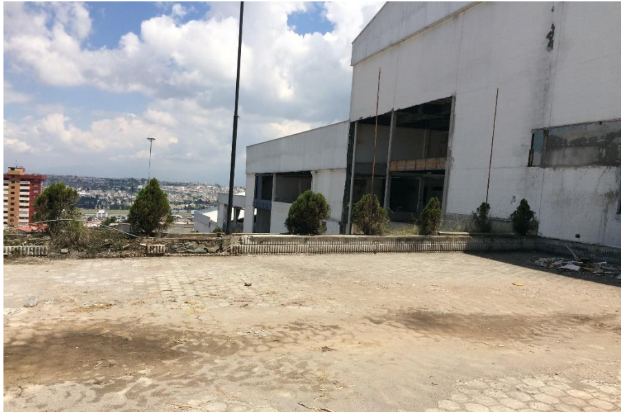
Fotografía 13: Plataforma ingreso 4to galpón
