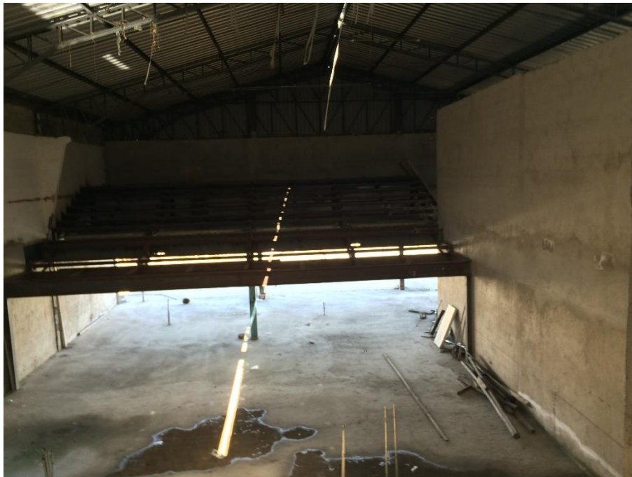
Fotografía 21: Estructura de graderío
