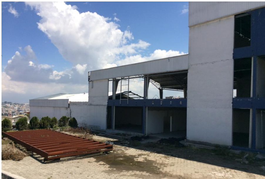
Fotografía 14: Plataforma ingreso 2do galpón
