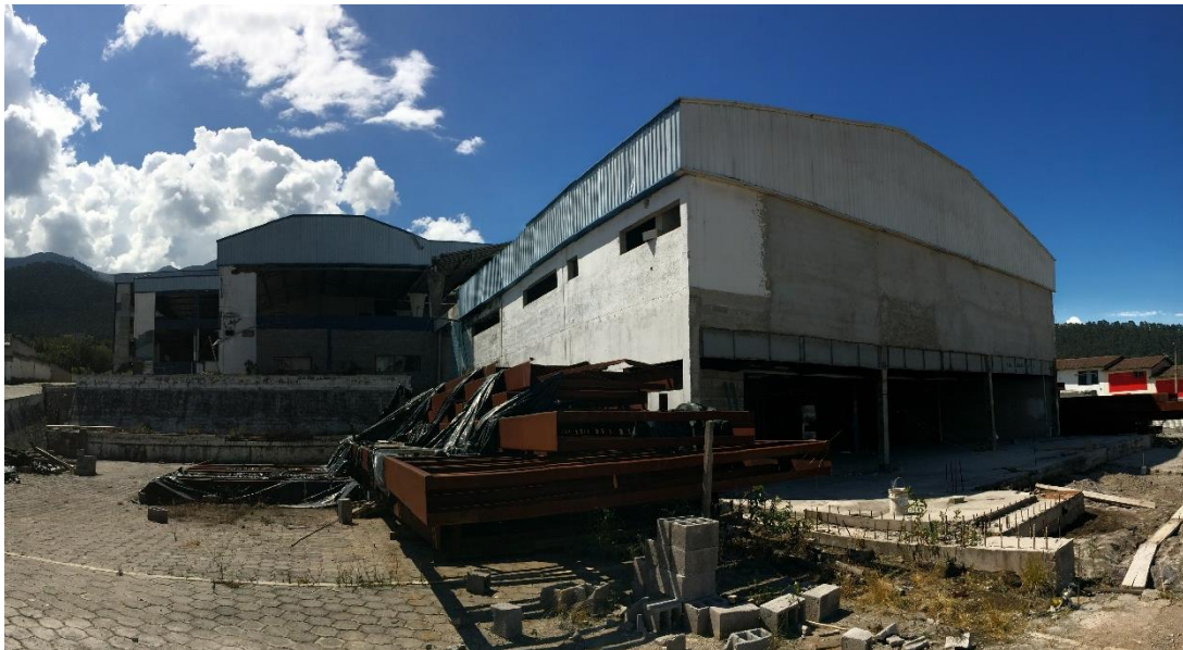
Fotografía 9: Galpones Industriales, Complejo Judicial “El Pedregal”
