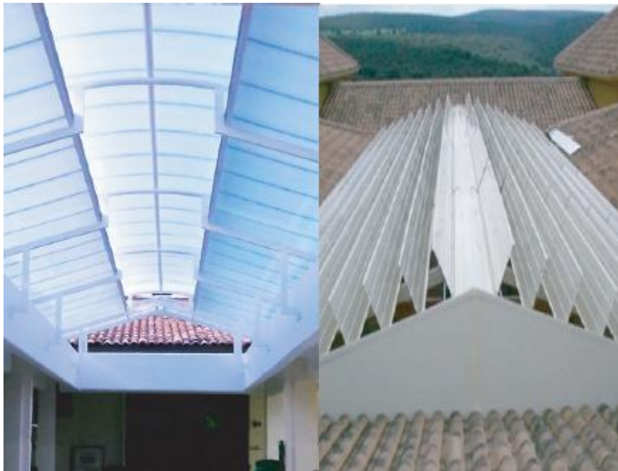
Fotografía 42: Estructuras especiales Para generar un efecto chimenea
