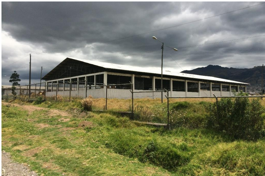
Fotografía 5: Fotografía Galpón Industrial barrio San Bartolo
