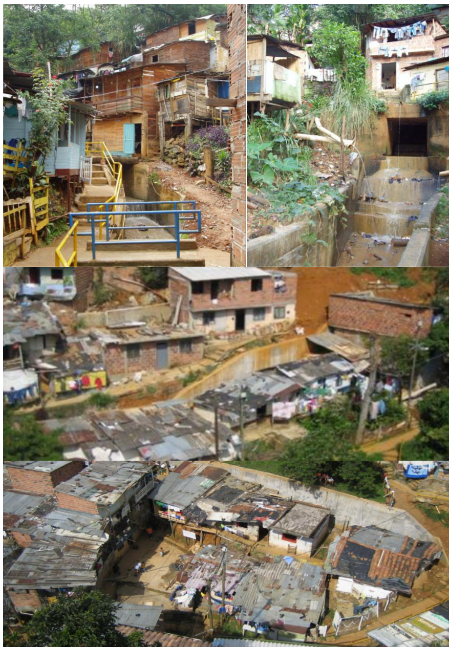
Conjunto de Fotografías 3: Previo a la intervención
