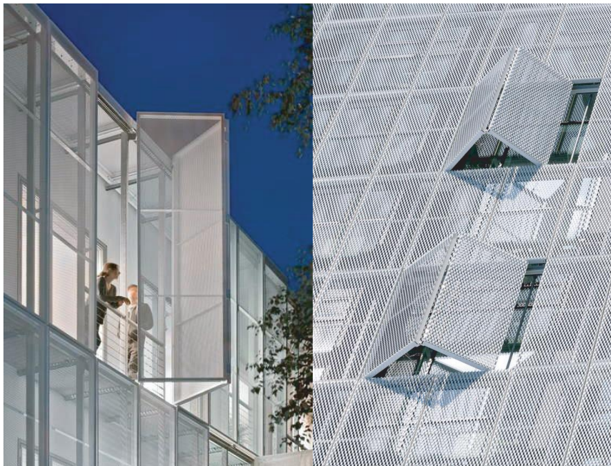
Fotografía 41: Paneles que dejan pasar el viento
