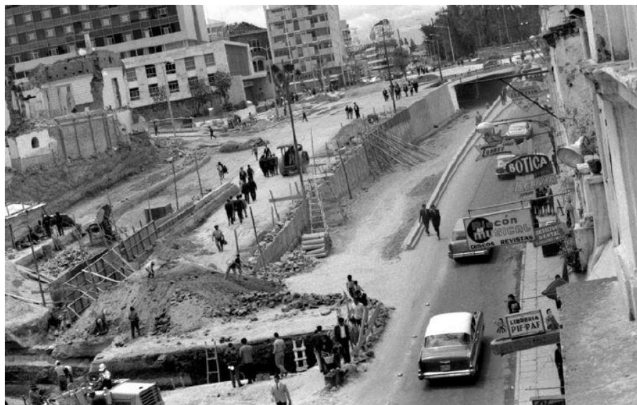
Figura 7. Construcción del paso a desnivel entre San Blas y la Alameda, 1967. Fuente: María A. Cifuentes, Planificación Urbana, modernización vial y cambios en la vida cotidiana de Quito (Revista Ecuatoriana de Historia PROCESOS)
