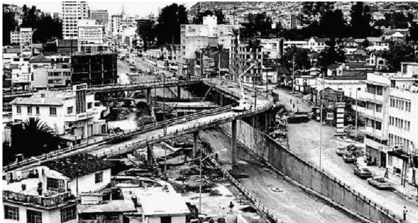
Figura 8. Construcción del paso a desnivel entre Orellana y 10 de agosto, 1978.
