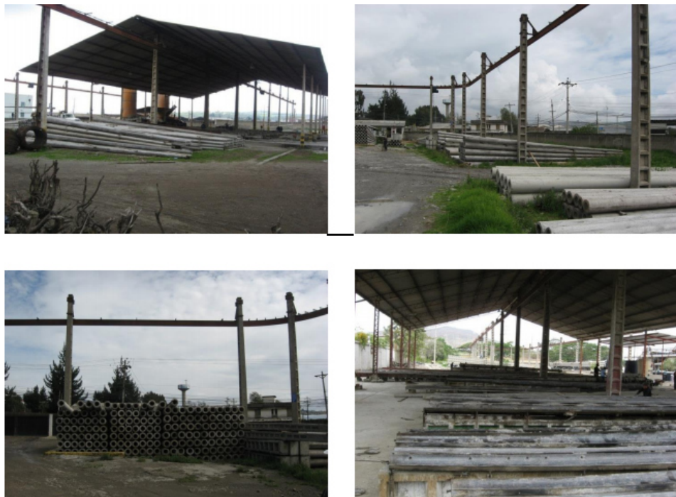
Figura 3: Postes de hormigón
