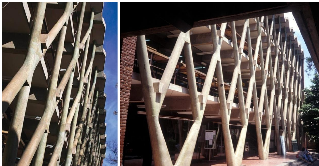
Figura 78: Edificio de la FAUM, exoestructura de hormigón. Tomado de: Flickr
