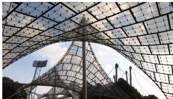
Figura 76: Estructura para los juegos Olímpicos de Munich 72. Tomado de: Plataforma Arquitectura.
