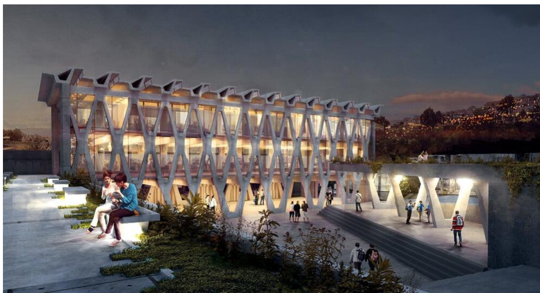
Figura 91: Equipamiento visto en la noche. Fuente: Elaboración propia.
