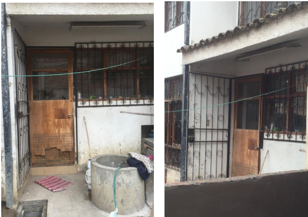
Imagen 4. 2: Instalaciones del establecimiento estado actual
