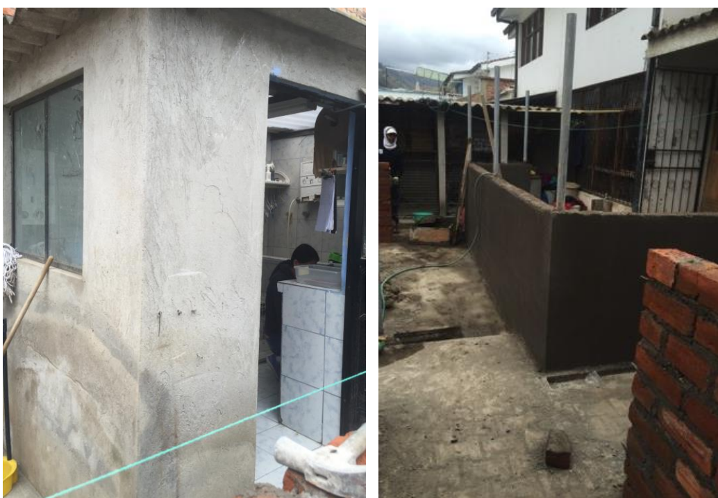
Imagen 4. 4: Instalaciones del establecimiento estado actual
