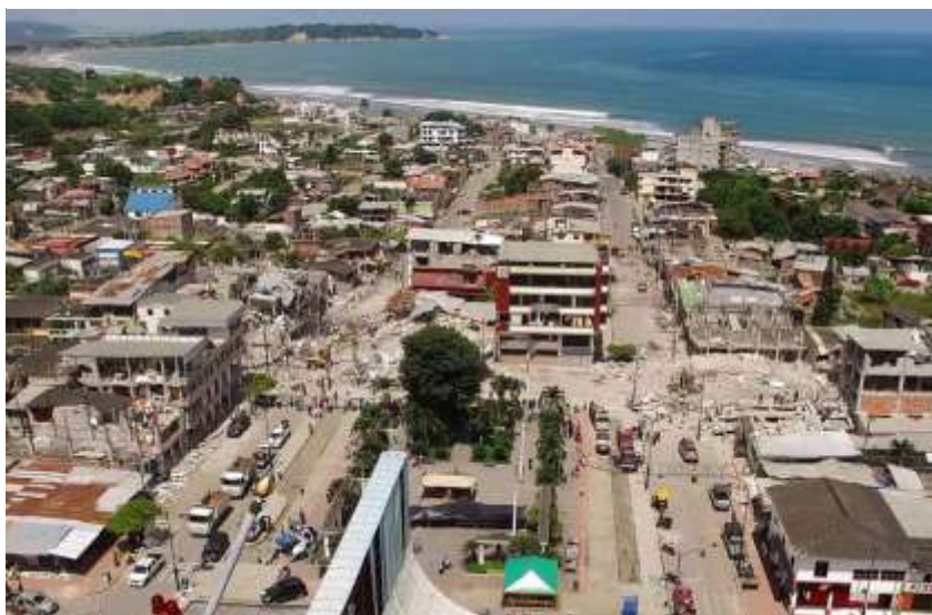
Fotografía 1: Imagen aérea de la ciudad de Pedernales Pos-Terremoto
