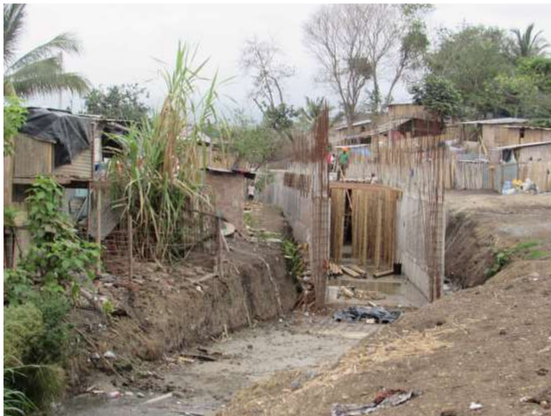
Fotografía 6: Ducto Cajón en Construcción
