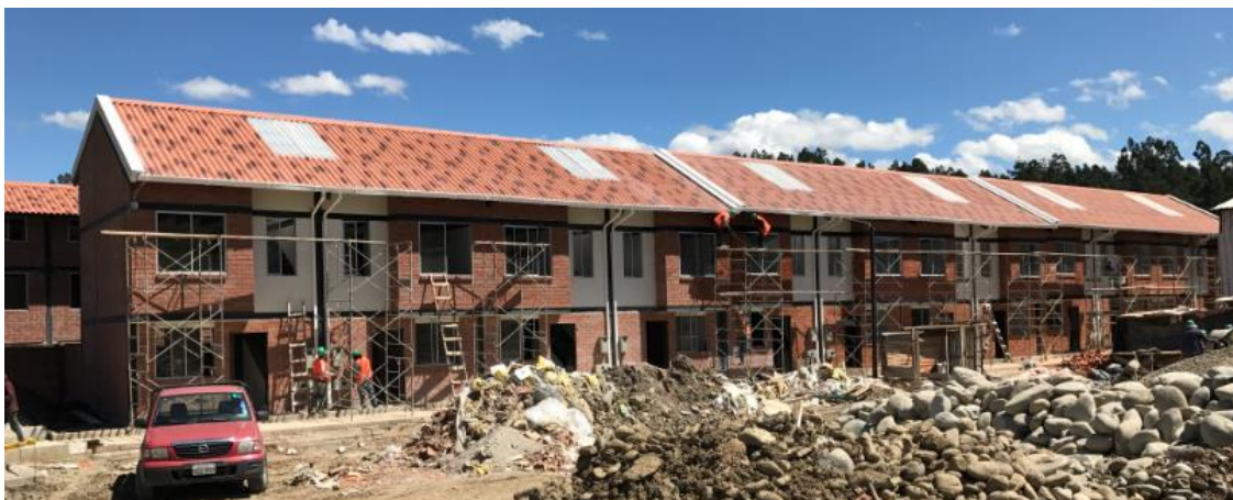
Gráfico 82: Módulos y juntas de construcción de viviendas de la segunda etapa del proyecto. Fotografía por: J. Ponce. Fecha de la imagen: 20/05/2017.
