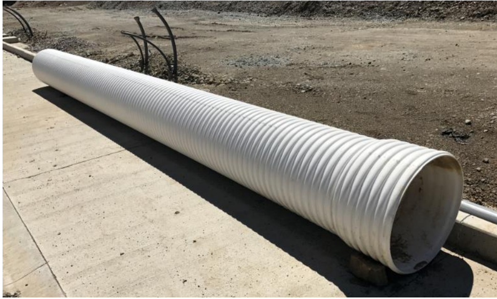
Gráfico 51: Tuberías de PVC de 500 mm. para alcantarillado sanitario. Fotografía por: J. Ponce. Fecha de fotografía: 23/06/2017.
