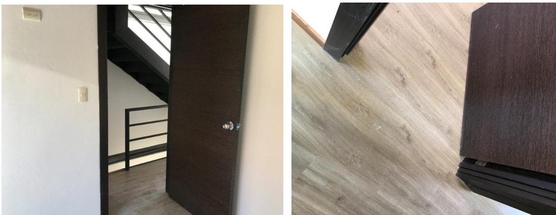
Gráfico 66: Terminados cuarto de planta alta de viviendas VIS de la primera etapa. Fotografías por: J. Ponce. Fecha de las imágenes: 20/05/2017.
