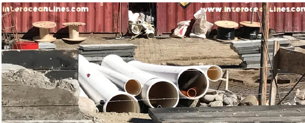
Gráfico 50: Tuberías de PVC para alcantarillado hidrosanitario del proyecto. Fotografía por: J. Ponce. Fecha de fotografía: 23/06/2017.
