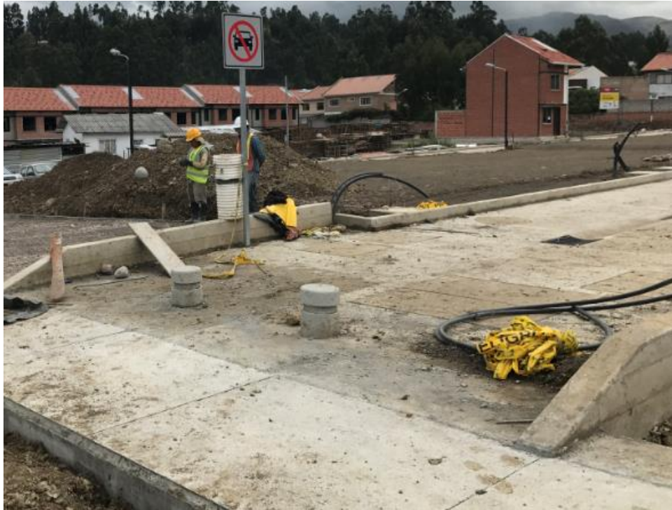
Gráfico 45: Construcción de las vías peatonales del proyecto. Fotografía por: J. Ponce. Fecha de fotografía: 20/06/2017.
