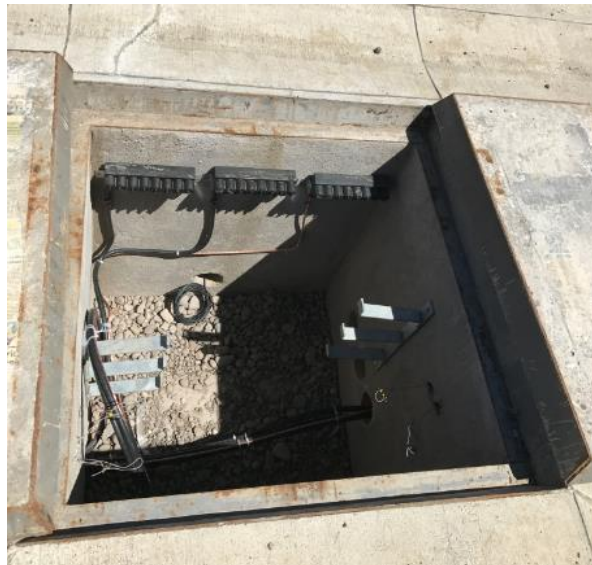
Gráfico 56: Caja de revisión de telecomunicaciones del proyecto. Fotografía por: J. Ponce. Fecha de la fotografía: 20/05/2017.
