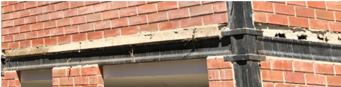
Gráfico 76: Vista inferior y lateral de NOVALOSA de viviendas. Fotografías por: J. Ponce. Fecha de las imágenes: 20/05/2017.
