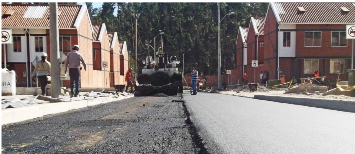
Gráfico 34: Asfaltado de vía vehicular principal del proyecto. Fecha de fotografía: Agosto del 2017. Fuente: Recuperado de: http://www.emuvi.gob.ec
