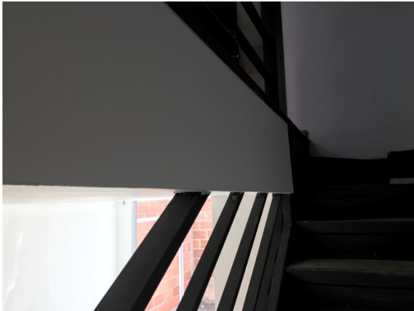
Gráfico 63: Cielo raso de gypsum instalado en techo de planta baja de viviendas VIS. Fotografía por: J. Ponce. Fecha de la imagen: 20/05/2017
