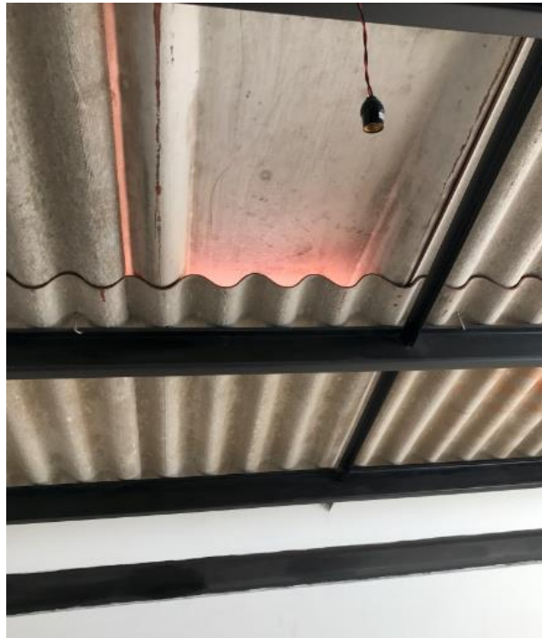
Gráfico 78: Vista inferior de cubierta y ventolera de viviendas VIP tipo 1 y tipo 2 del proyecto. Fotografía por: J. Ponce. Fecha de la imagen: 20/05/2017.
