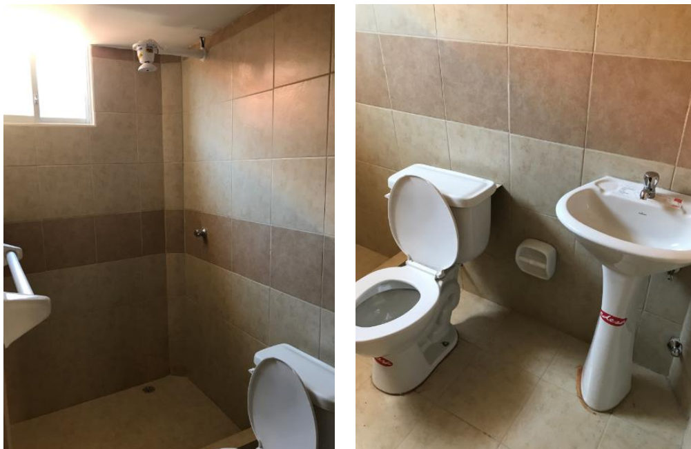
Gráfico 68: Terminados de cuarto máster de viviendas VIS de la primera etapa. Fotografías por: J. Ponce. Fecha de las imágenes: 20/05/2017.
