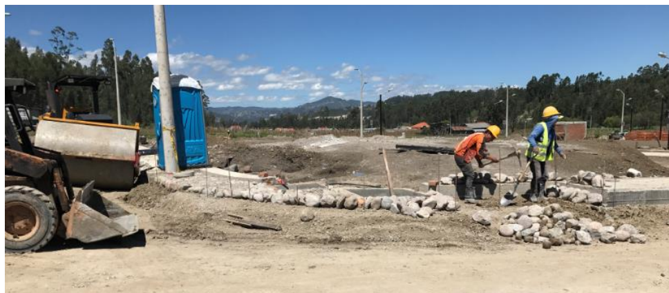
Gráfico 41: Construcción de vereda y detalle de trazado vial. Fotografía por: J. Ponce. Fecha de la fotografía: 20/05/2017.
