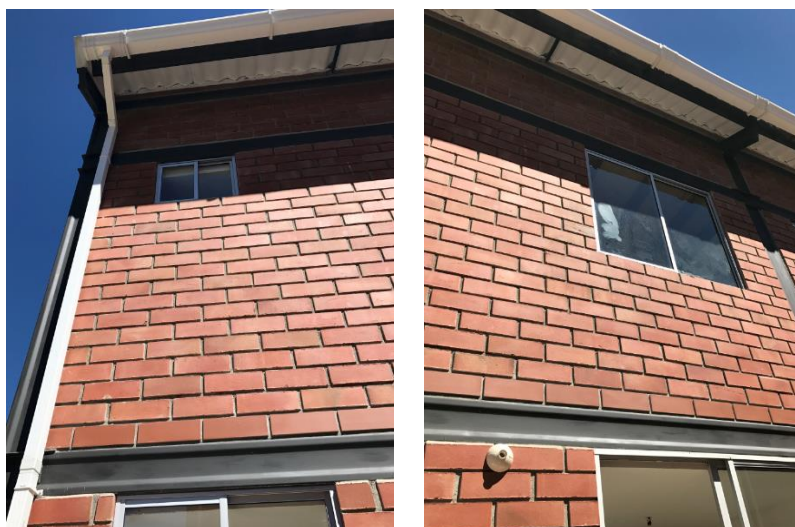
Gráfico 60: Fachada posterior de viviendas VIS de la primera etapa del proyecto. Fotografías por: J. Ponce. Fecha de las imágenes: 20/05/2017.
