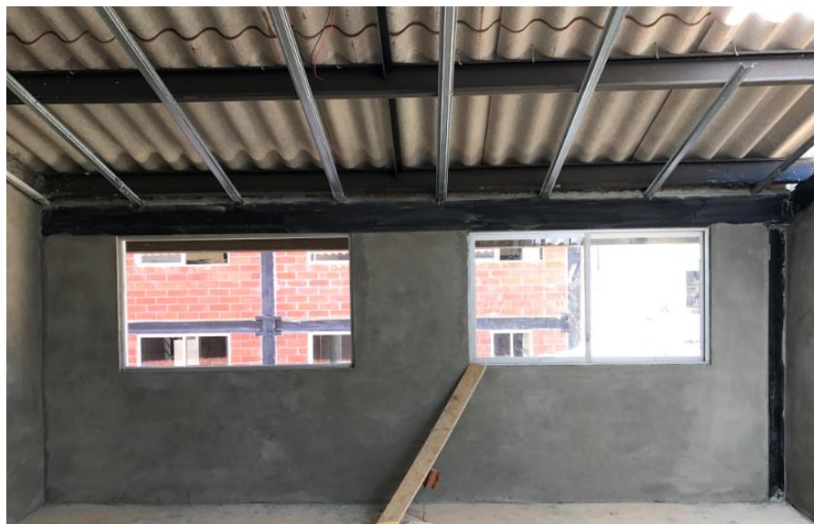
Gráfico 79: Ventanales de buhardilla de viviendas de segunda etapa. Fotografía por: J. Ponce. Fecha de la imagen: 20/05/2017.
