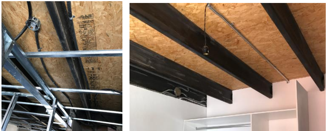
Gráfico 86: Cableado y acabados de luminaria de viviendas tipo 1 y 2 del proyecto. Fotografías por: J. Ponce. Fecha de las imágenes: 20/05/2017.
