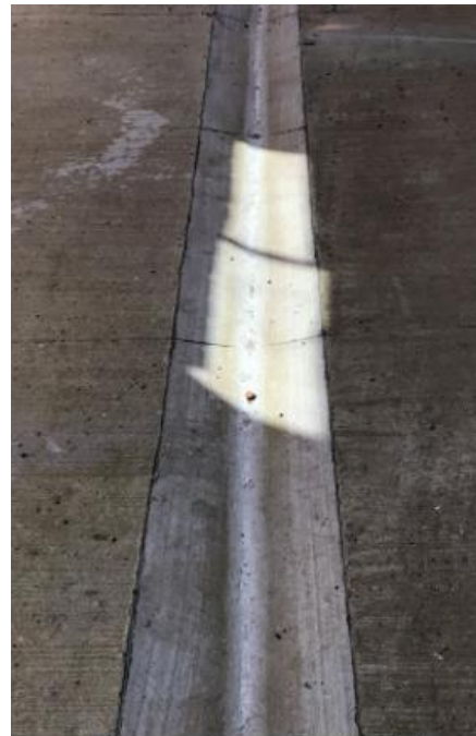
Gráfico 46: Vías peatonales y detalle de cuneta central del proyecto. Fotografía por: J. Ponce. Fecha de fotografía: 20/06/2017.
