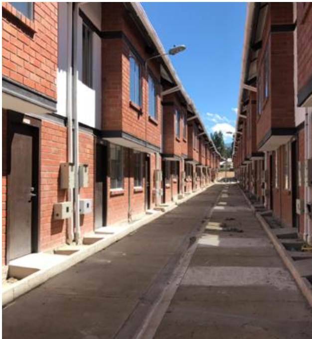
Gráfico 46: Vías peatonales y detalle de cuneta central del proyecto. Fotografía por: J. Ponce. Fecha de fotografía: 20/06/2017.
