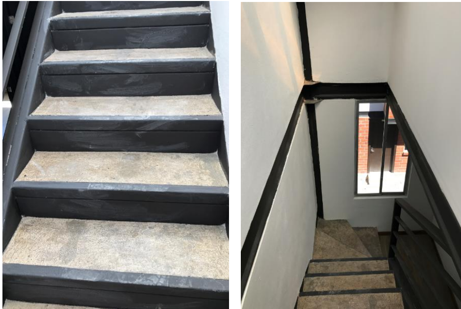
Gráfico 65: Terminados de gradas de viviendas VIS de la primera etapa del proyecto. Fotografía por: J. Ponce. Fecha de la imagen: 20/05/2017.
