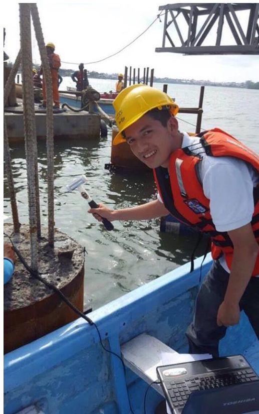
Gráfico 2-17 EJECUCIÓN DEL ENSAYO DE ECO Fuente: (Josué Zumba, 2016)
