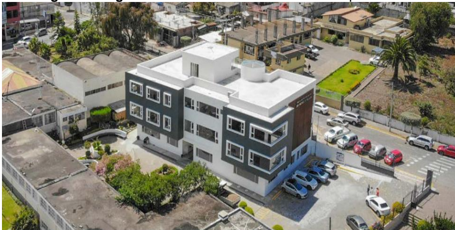
Registro fotográfico 1. Instalaciones del GAD Municipio de Pelileo
