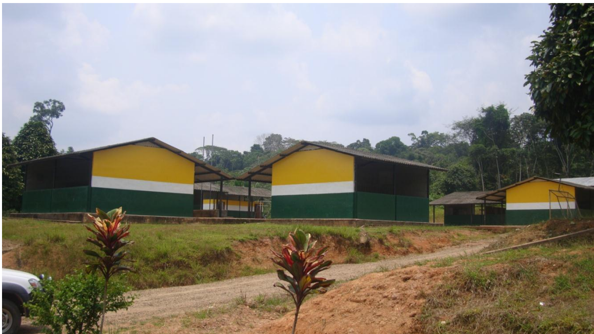
Figura 3.4: Infraestructura civil Infocentro de la Comunidad de Silvayaku Fotografía tomada por: Danilo Mejía Suárez.
