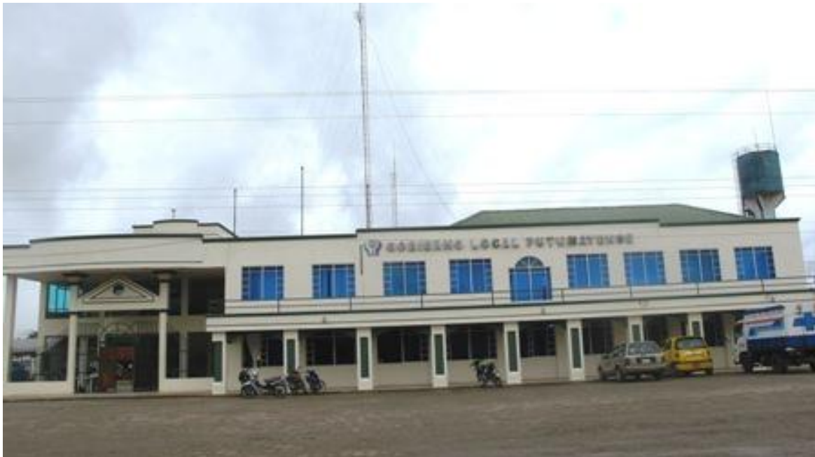
Figura 3.3: Torre del GAD Municipal de Putumayo Fotografía tomada por: Danilo Mejía Suárez.
