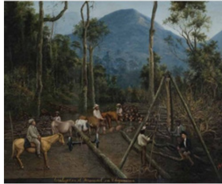
Figura 7: Trabajos en el ferrocarril en Chiguacán, José Grijalva, 1907. Recuperado de https://journals.openedition.org/artelogie/821?lang=pt
