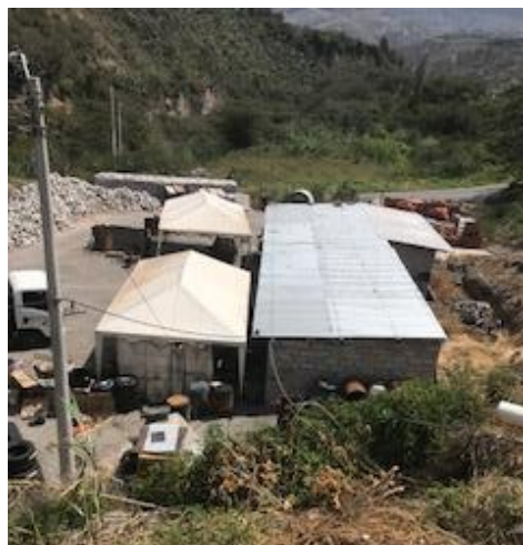
Figura 9. Muestra las instalaciones de almacenamiento de aceites de la empresa.
