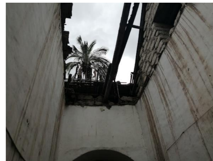
Figura 242. Corredor hacia la lavandería. Fuente: Elaboración propia.
