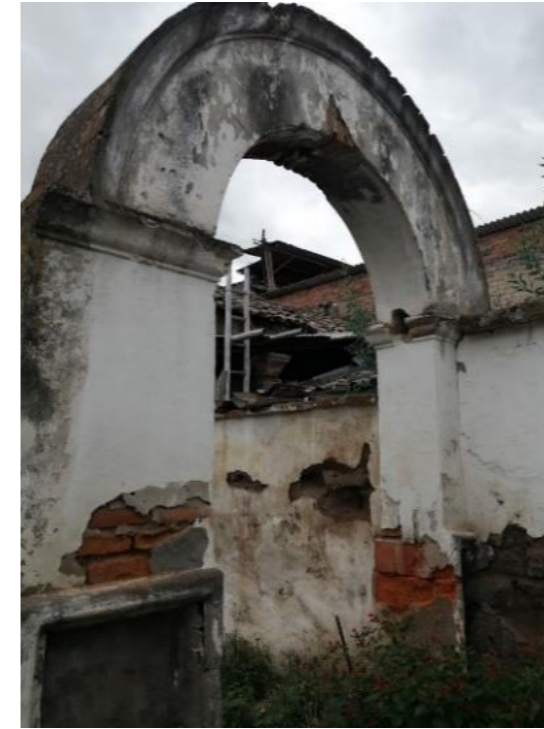
Figura 238. Ingreso lavandería y corredor lateral izq. Fuente: Elaboración propia.
