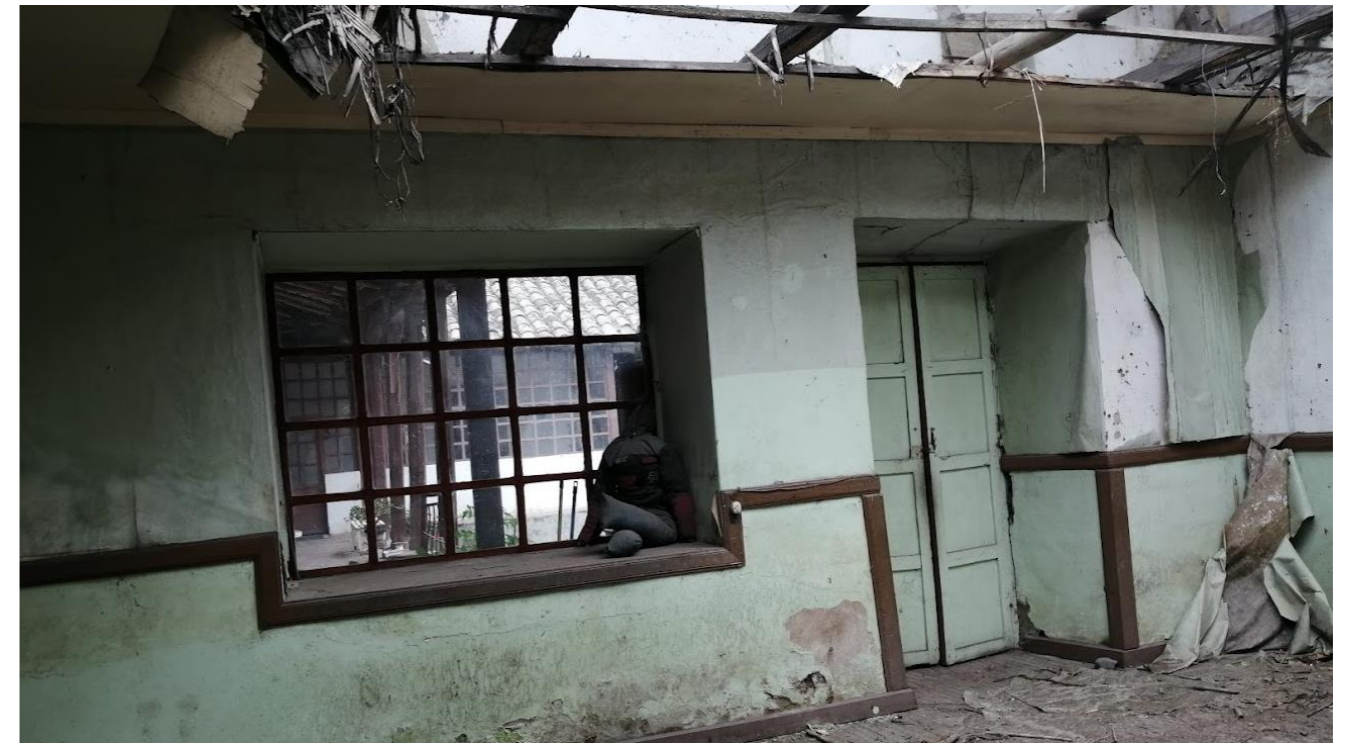
Figura 289. Estado actual espacio sin uso (cocina). Fuente: Elaboración propia.
