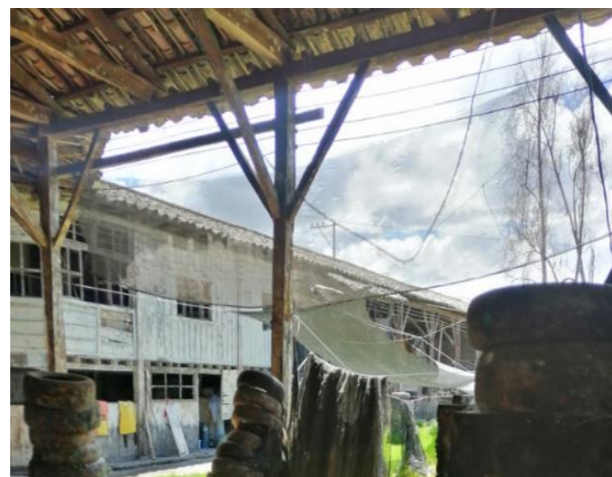
Figura 158. Vista Galpón La Curtiembre Fuente: Elaboración Propia
