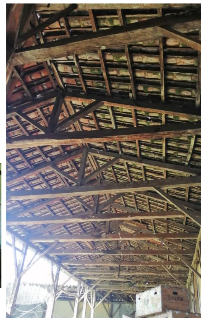
Figura 161. Cubierta Galpón La Curtiembre Fuente: Elaboración Propia
