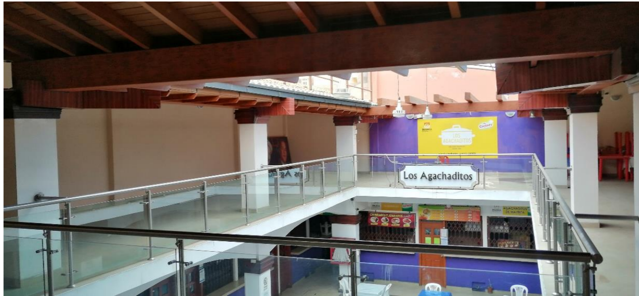
Figura 208. Balcón "LOS AGACHADITOS DE LA MERCED" Fuente: Elaboración Propia
