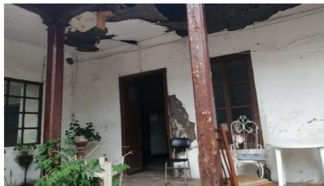
Figura 227. Ingreso habitación principal
