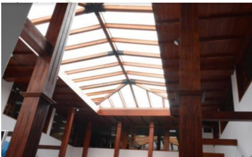
Figura 62. Cubierta Registro Civil, Identificación y Cedulación Fuente: Elaboración Propia
