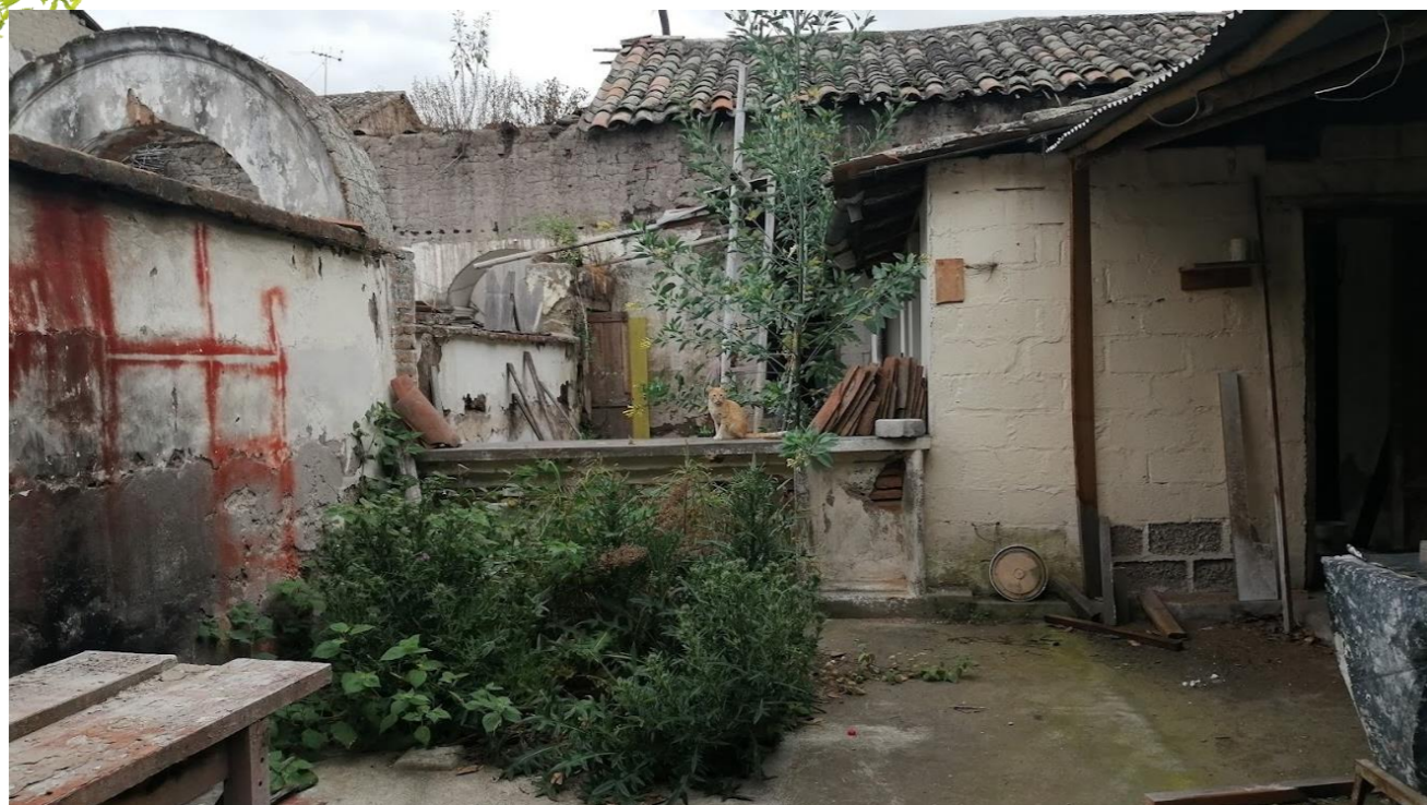
Figura 291. Estado actual patio posterior.
