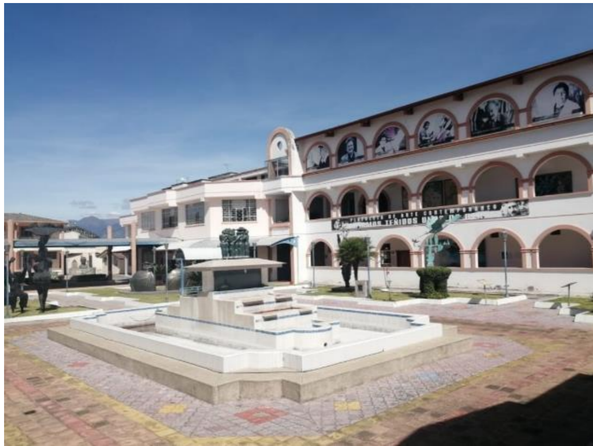
Figura 96. Fuente de agua Casa de la Cultura Fuente: Elaboración Propia
