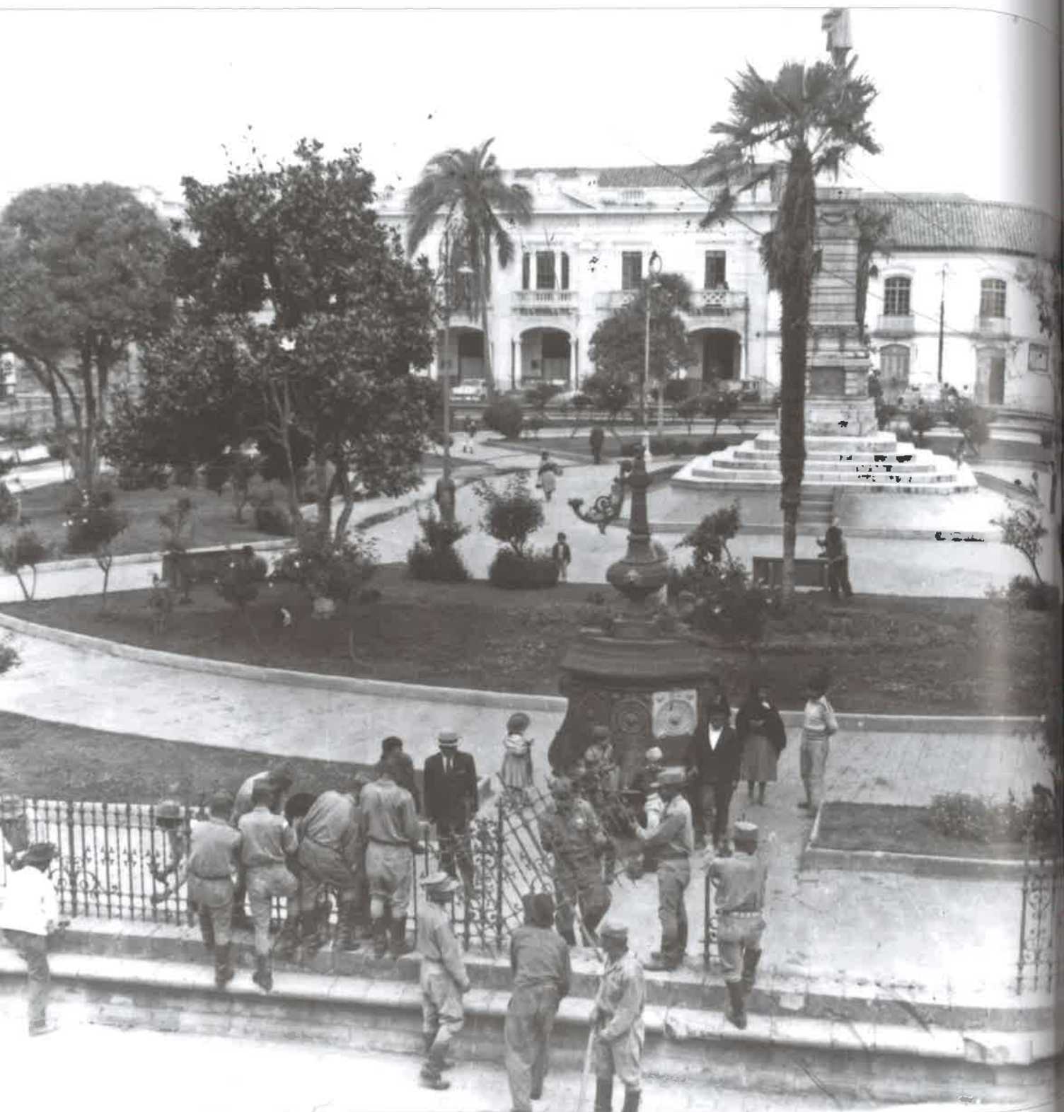
34| RETIRO DE LAS REJAS DEL PARQUE MALDONADO
