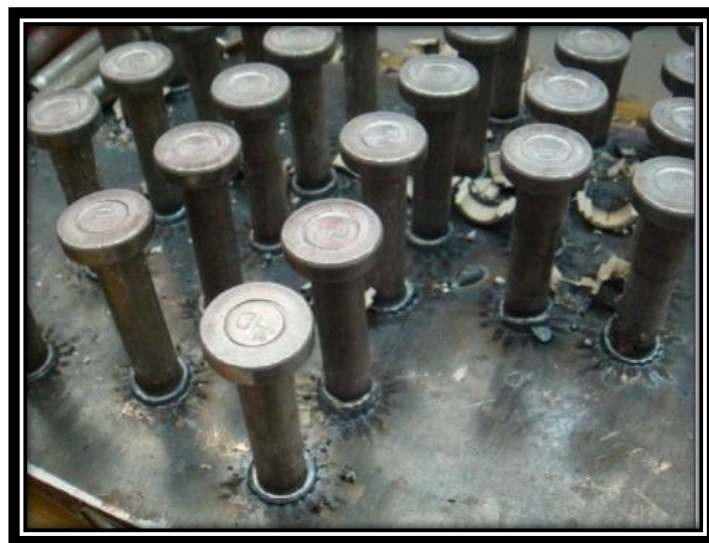
Figura 6. 2 Conectores tipo Espárrago. Referencia 32.
