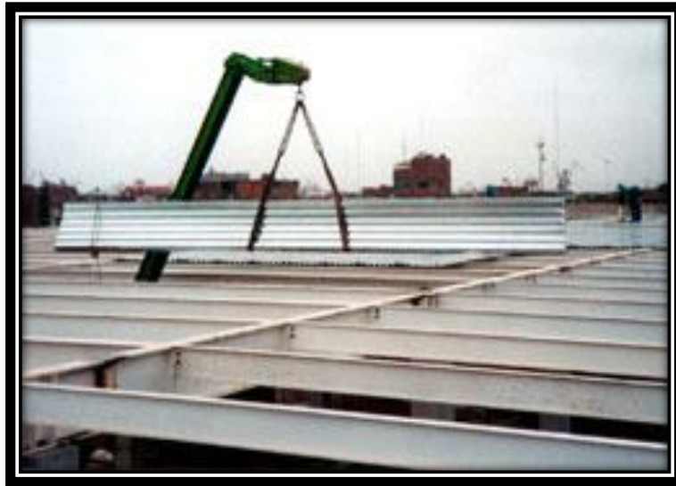
Figura 5. 6 Izaje Mecánico del Panel Metálico. Referencia 30.
