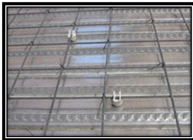
Figura 5. 9 Refuerzo por Temperatura en Paneles Metálicos. Referencia 30.
