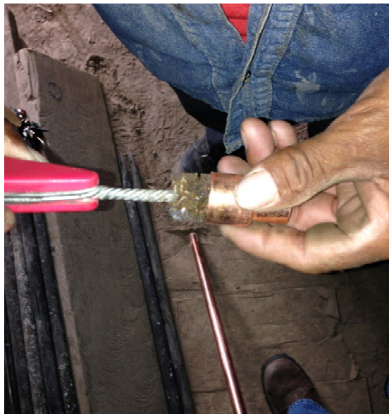
FOTO 16. Fotografía de proceso de soldado de tubería de cobre.
