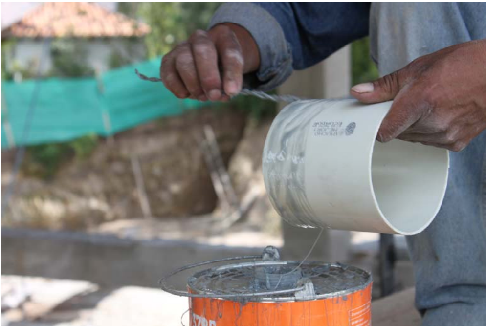
FOTO 21. Fotografía de la colocación de pegamento en la tubería para posterior pegado.
