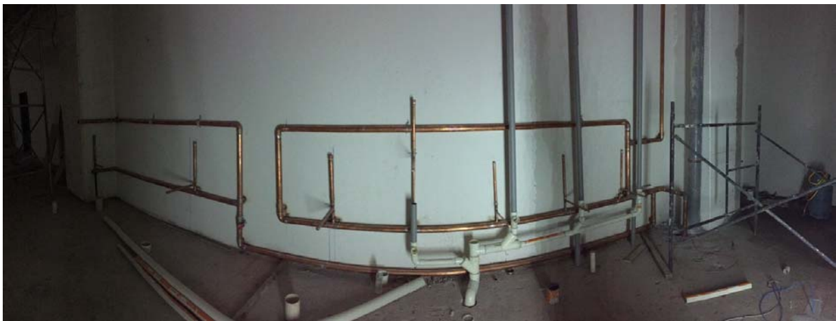
FOTO 17. Fotografía de instalaciones definitivas de tuberías de cobre con las alturas respectivas y correspondientes a los diferentes aparatos sanitarios.
