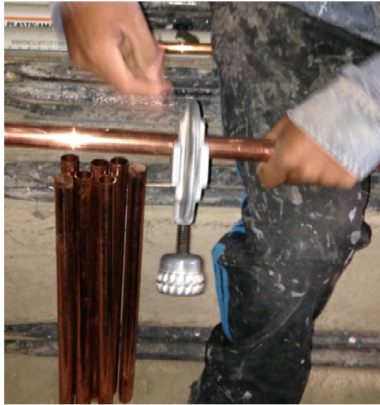
FOTO 15. Fotografía de lijado de accesorios y tubería de cobre antes de proceder a soldar.
