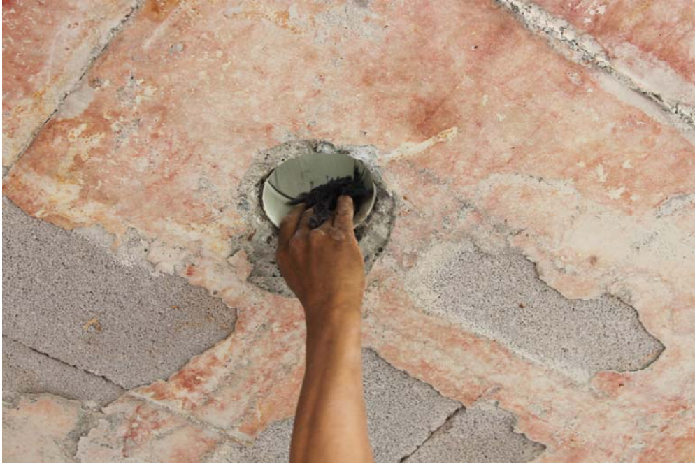
FOTO 21. Fotografía de la colocación de pegamento en la tubería para posterior pegado.
