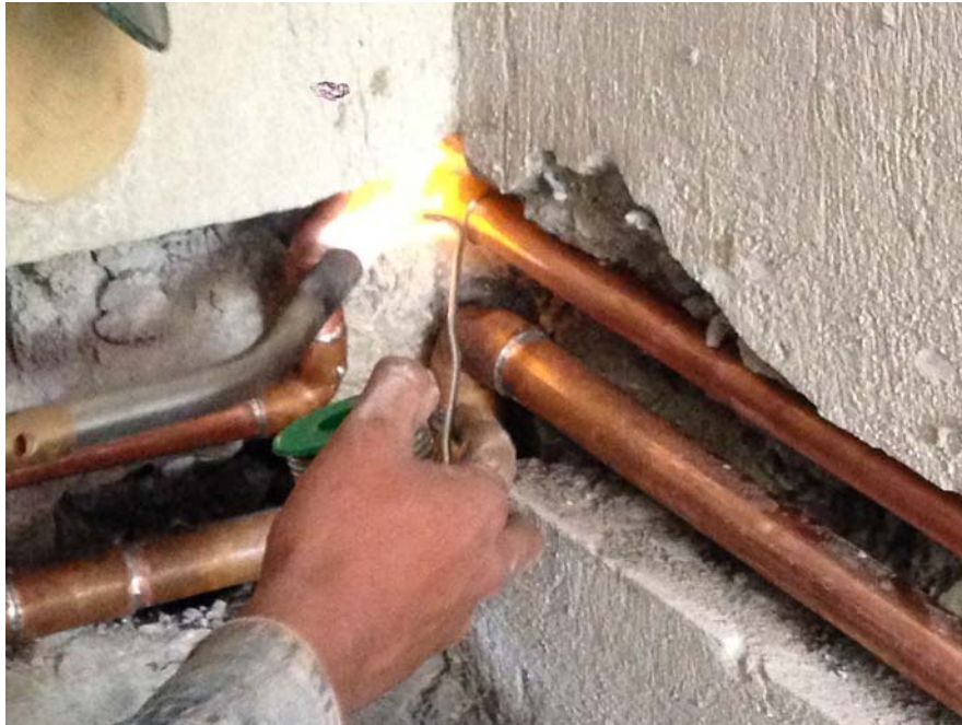
FOTO 17. Fotografía de instalaciones definitivas de tuberías de cobre con las alturas respectivas y correspondientes a los diferentes aparatos sanitarios.
