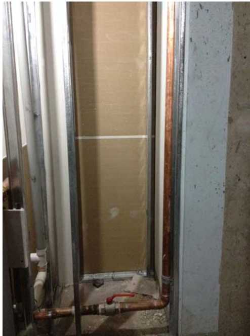
FOTO 20. Fotografía de limpieza de tubería de PVC desagüe con trapo húmedo y líquidos con químicos.
