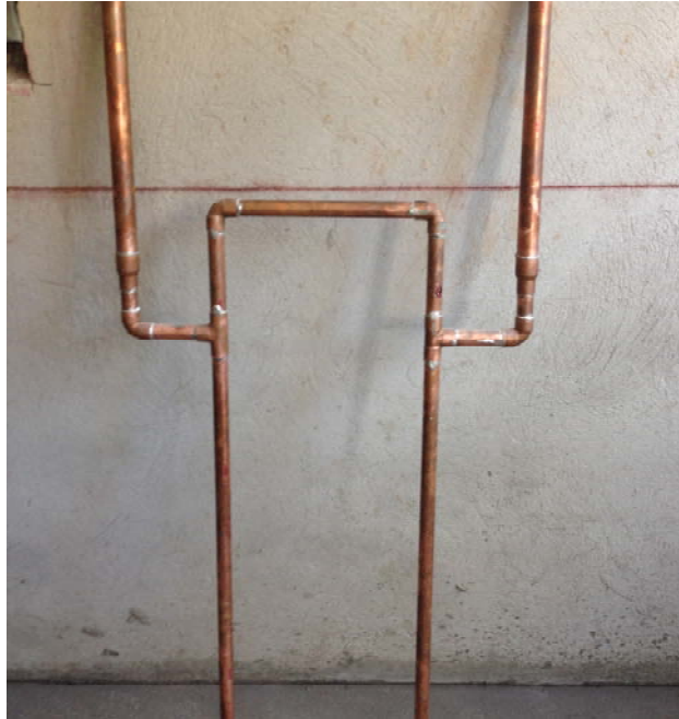
FOTO 19. Fotografía de una válvula de compuerta para el funcionamiento de un baño.
