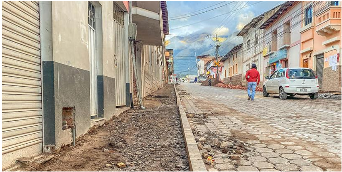
Figura 92: Vista readecuación calle General Enríquez Fuente: Elaboración propia
