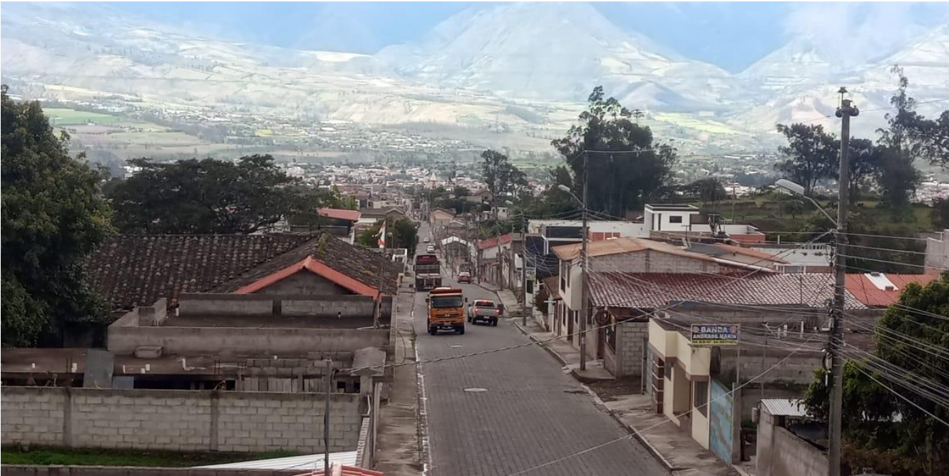
Figura 69: Vista panorámica hacia el norte calle General Enríquez Fuente: Elaboración propia
