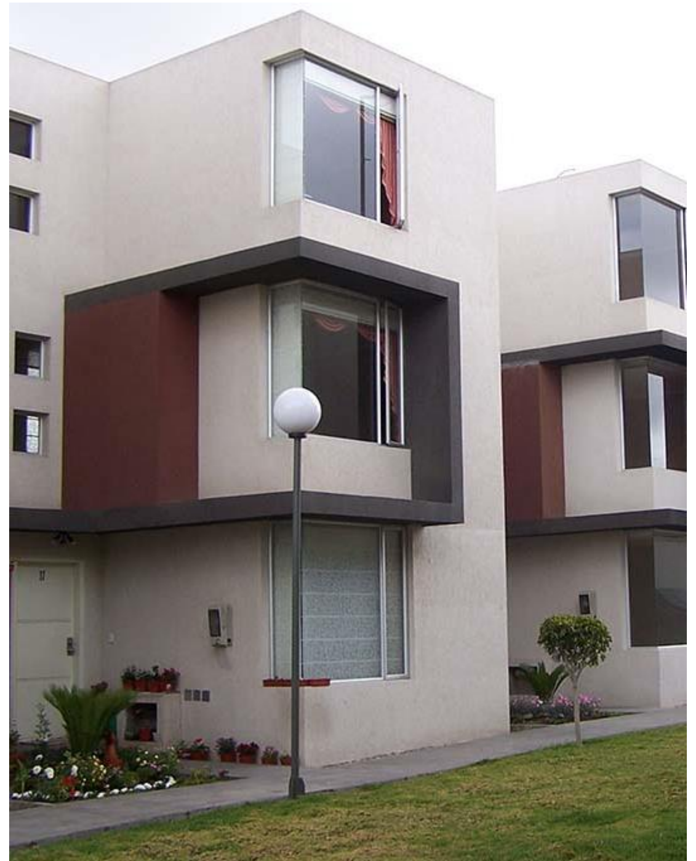
Figura 51: Vista 2 Vivienda Social de Carapungo Fuente: https://www.arquitecturapanamericana.com/vivienda-social-en-carapungo/
