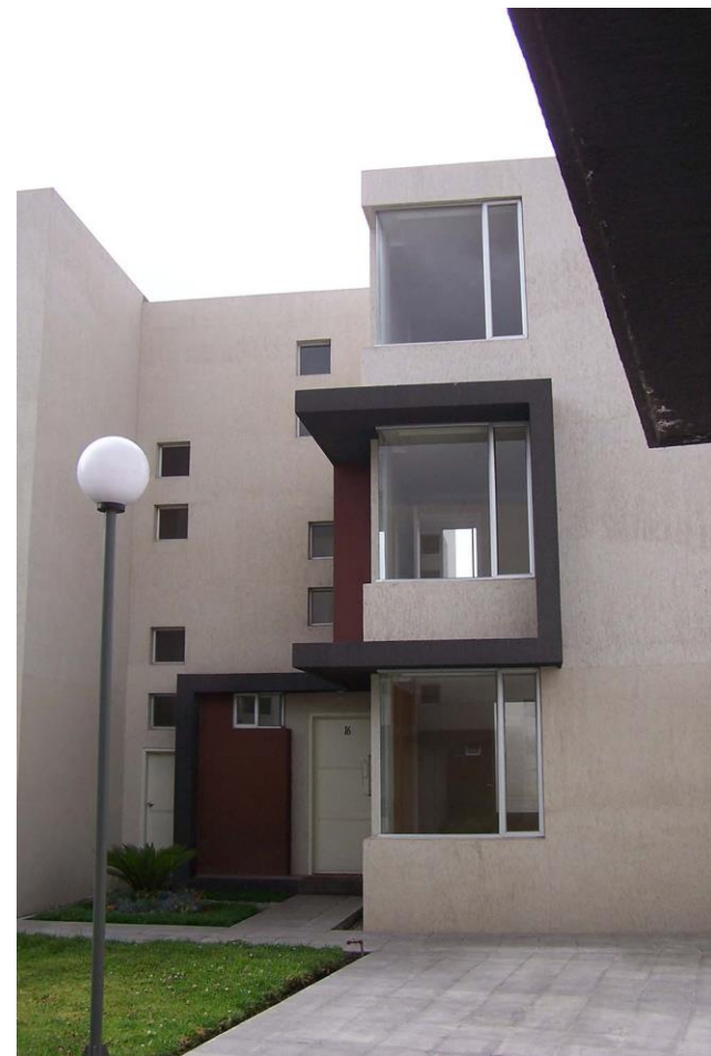
Figura 50: Vista 1 Vivienda Social de Carapungo Fuente: https://www.arquitecturapanamericana.com/vivienda-social-en-carapungo/
