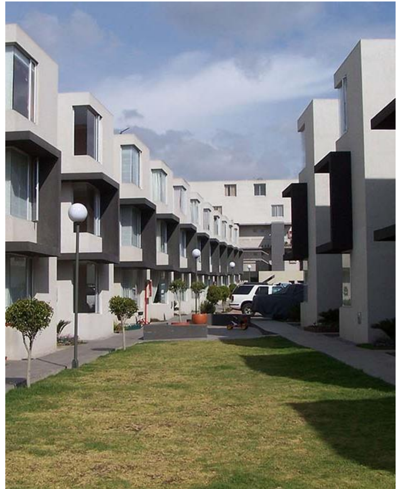
Figura 57: Vista 4 Vivienda Social de Carapungo
