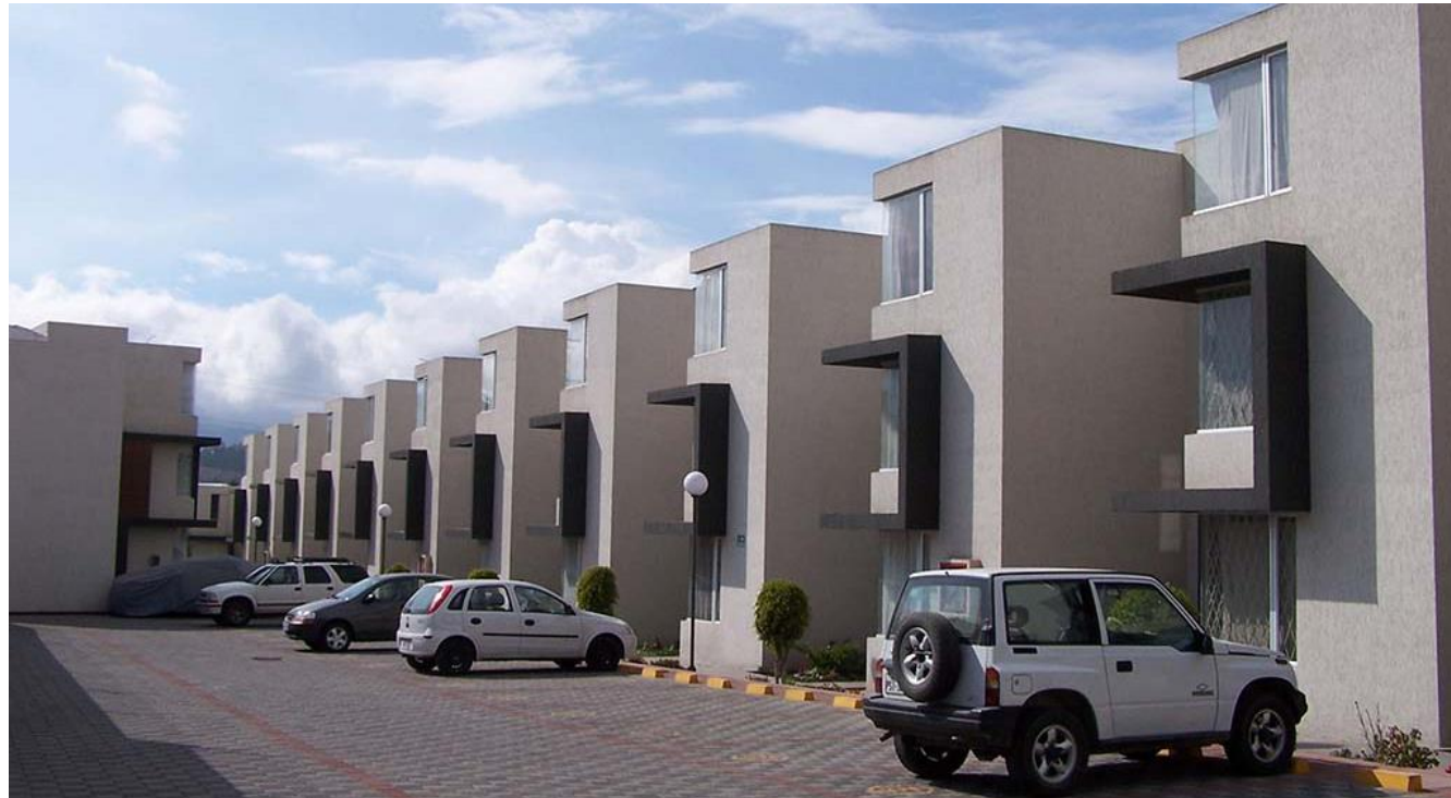
Figura 56: Vista 3 Vivienda Social de Carapungo
