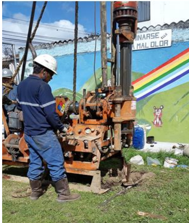
Gráfico 19: Proceso de roto-percusión de máquina Aker -ace
