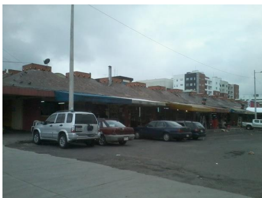
Fotografía 4 Vista exterior del mercado
