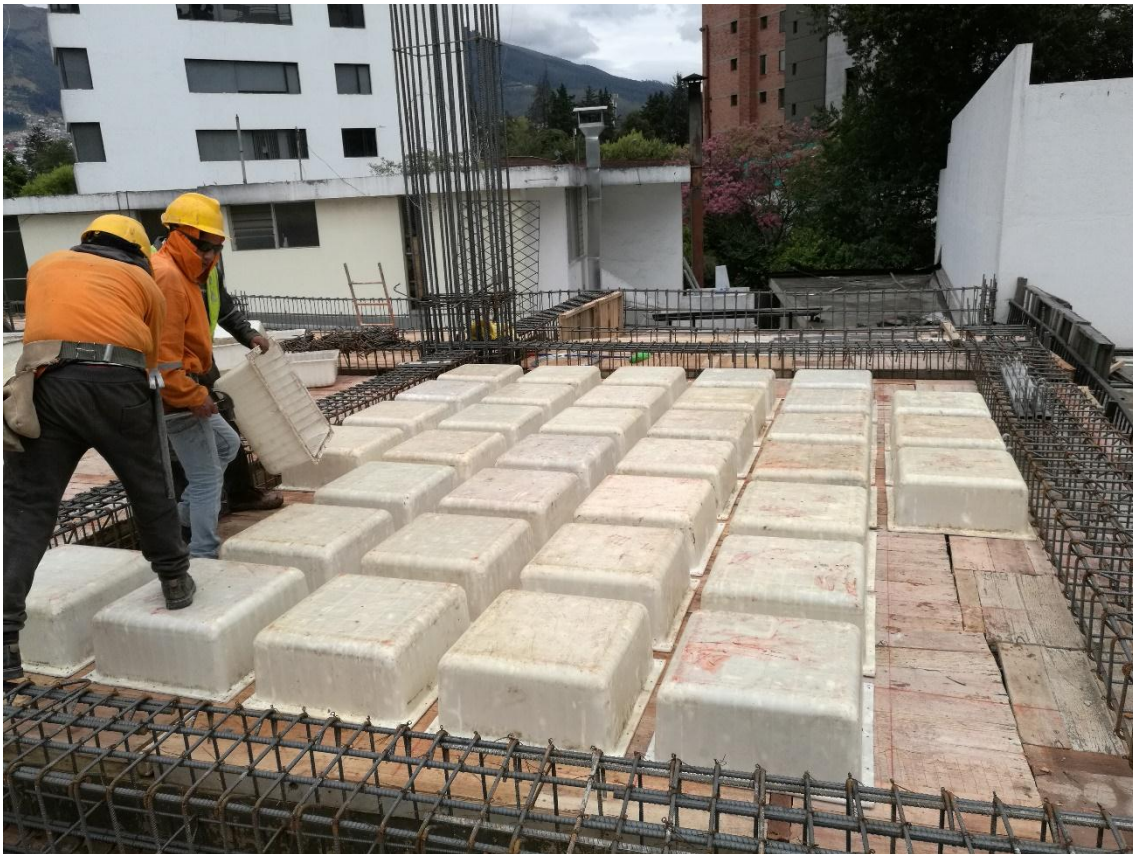
Fotografía 5: Paso dos del uso del casetón modular
