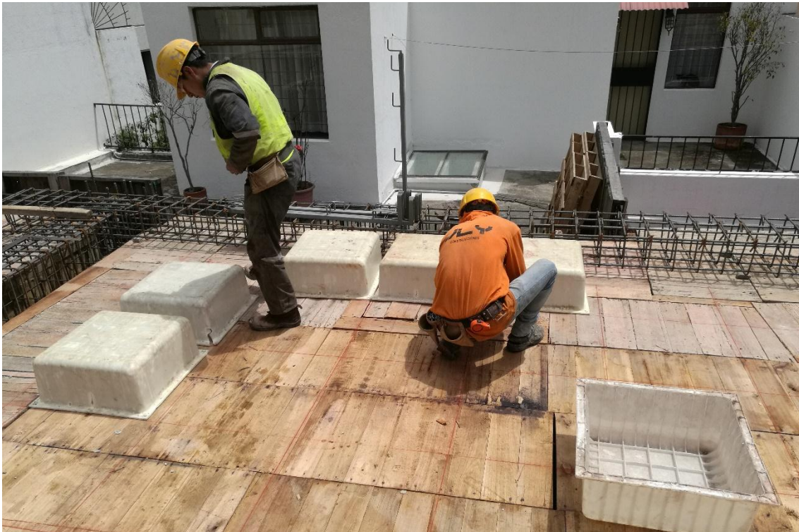
Fotografía 8: Aseguramiento de casetones ubicados y alineados
