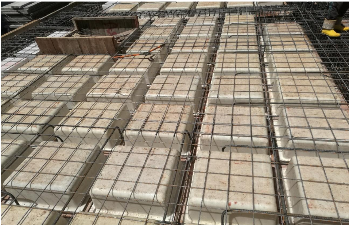
Fotografía 11: Losa con casetones modulares reutilizados
