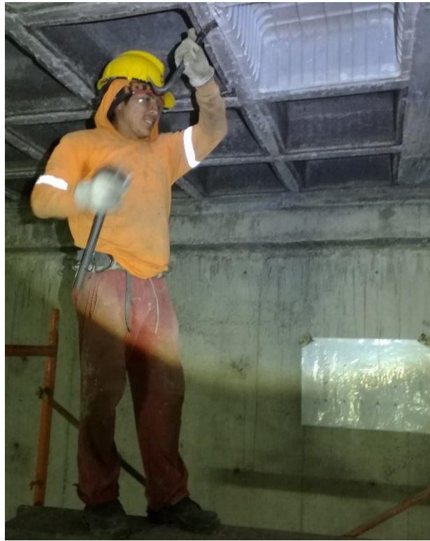
Fotografía 10: Retiro de casetón modular
