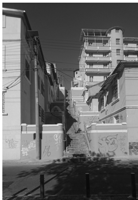
Figura 13: Escalinatas peatonales dentro de los barrios La Tola, La Loma, La Recoleta y Luluncoto
