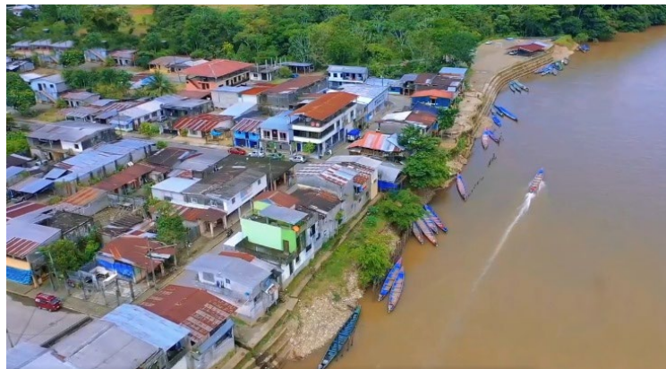
Figura 7 Vista del Malecón de la Parroquia
