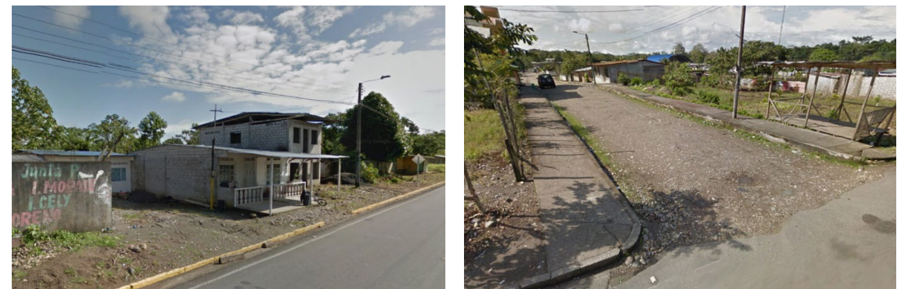
Figura 67: Estado actual de las aceras
