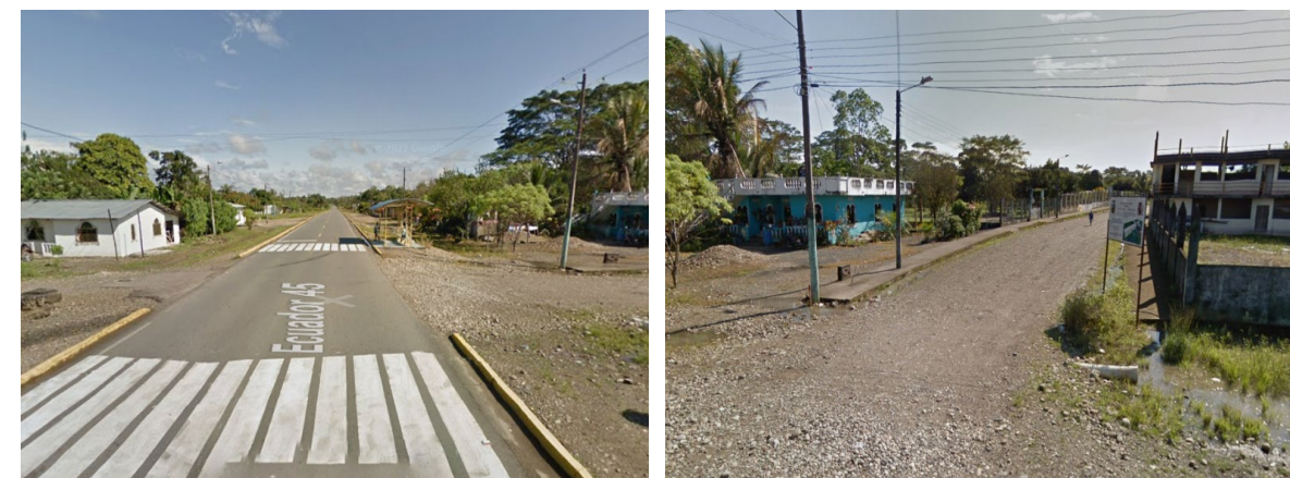
Figura 63: Estado de las vías
