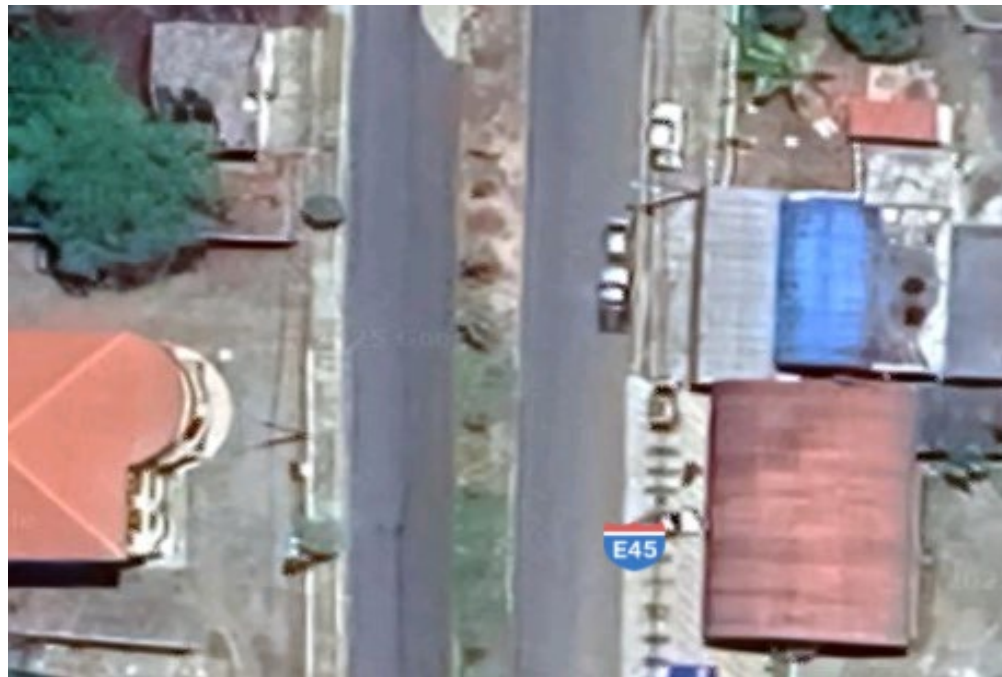
Figura 122: Tramo 2 – Estado Actual Fuente: Google Maps
