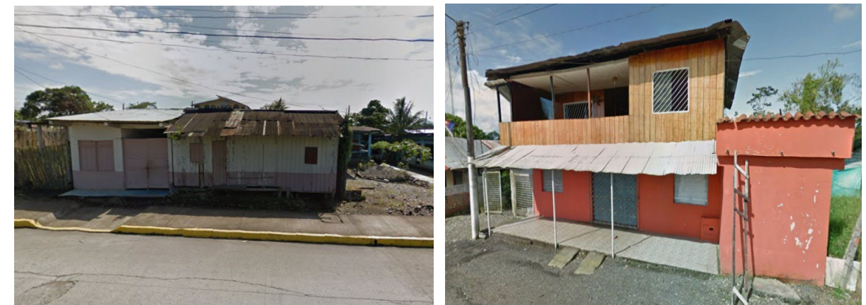
Figura 58: Fotografía de Altura de Edificaciones
