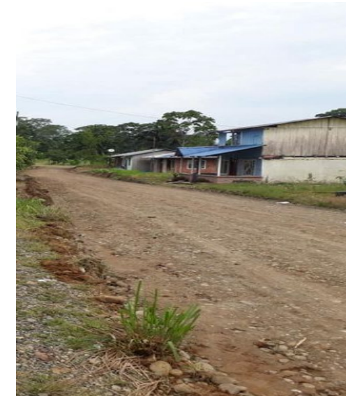
Figura 1. Estado actual de las vías y aceras
