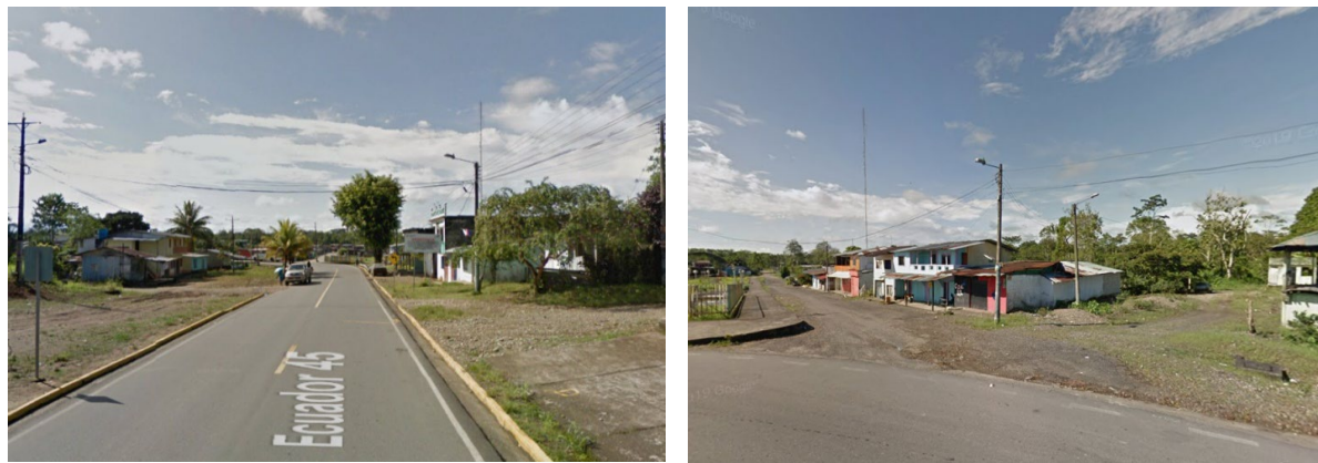
Figura 64: Estado de Vías
