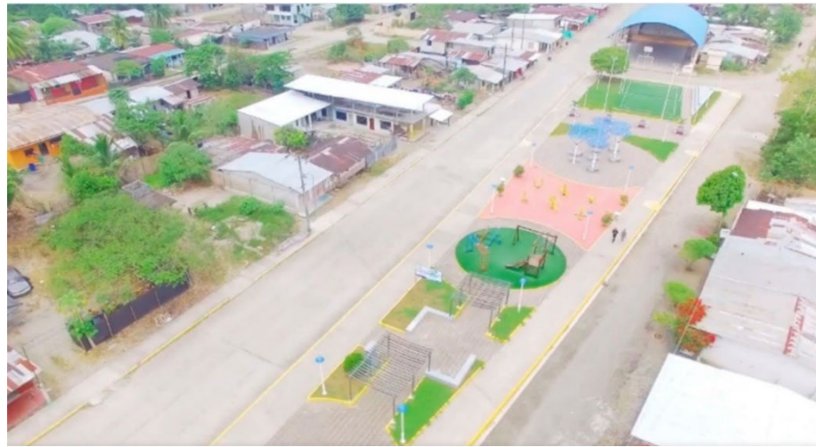
Figura 8: Estado Actual Espacio Público
