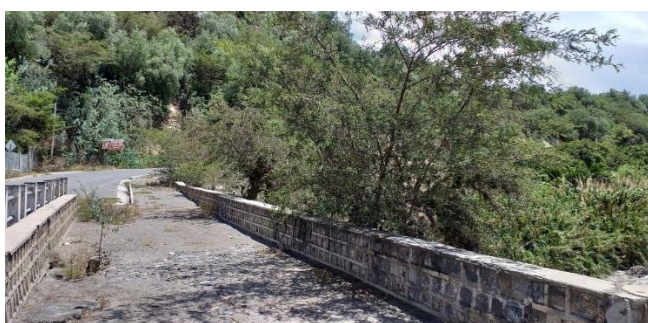
Figura 76: El puente viejo de Chota Fuente: Katya Mosquera (2019)
