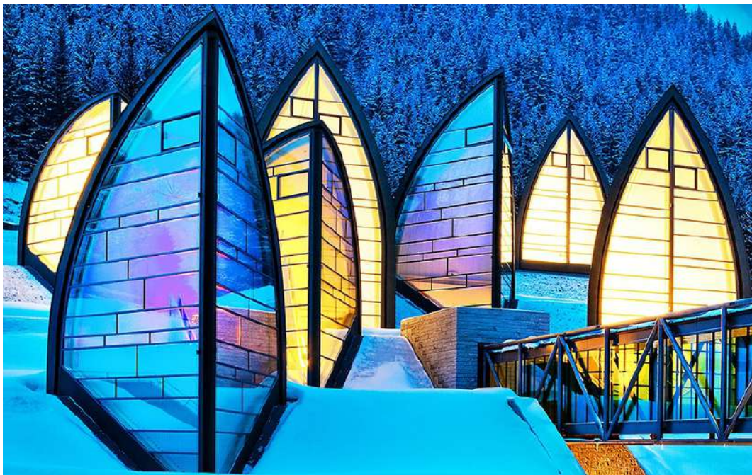
Imagen 2.10 Fachada frontal del Spa Berg Oase
