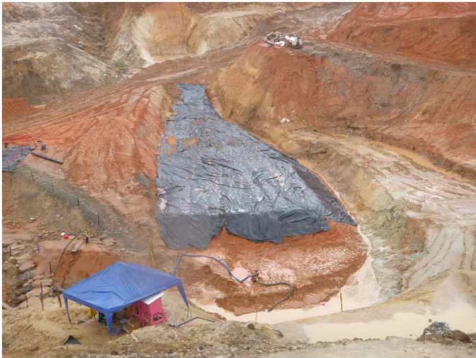
Figura 10.- protección con plásticos contra lluvia y construcción de drenes perimetrales para protección
