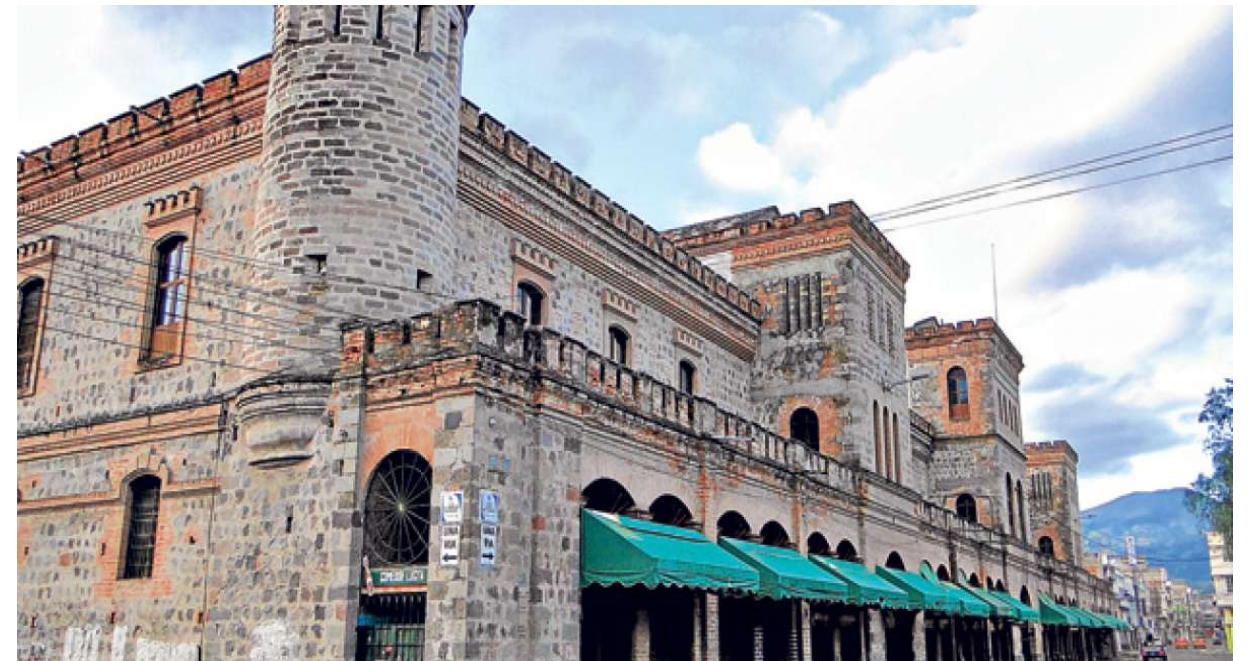
Figura 2: Vista antiguo cuartel de Ibarra
