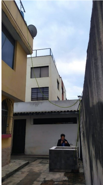
Imagen 27. Medición termográfica en recubrimiento cerámico.
