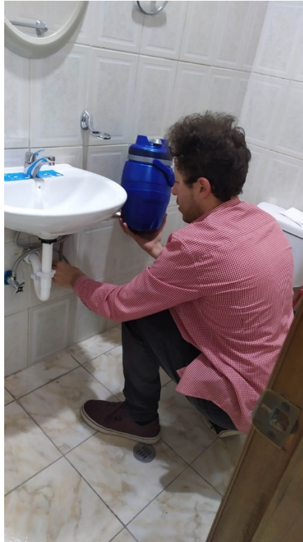
Imagen 16. Acoplamiento de tanque de suministro de agua en llave de abasto lavamanos.
