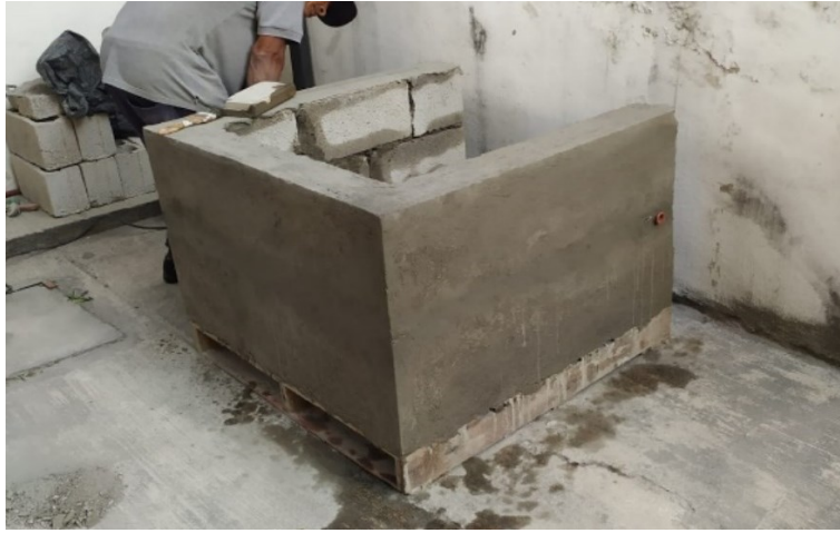
Imagen 22. Infraestructura del muro de pruebas (resane de tubería)
