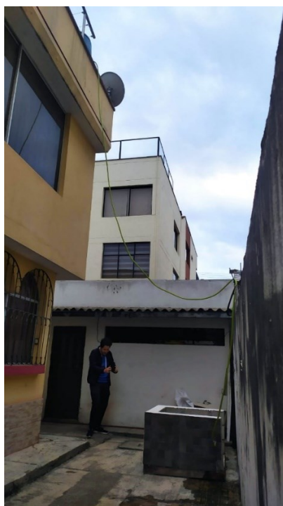
Imagen 17. Tanque de presión
