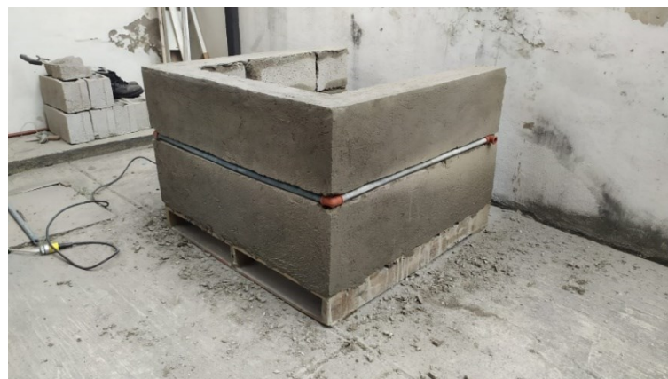
Imagen 21. Infraestructura de muro de pruebas (colocación de tubería)
