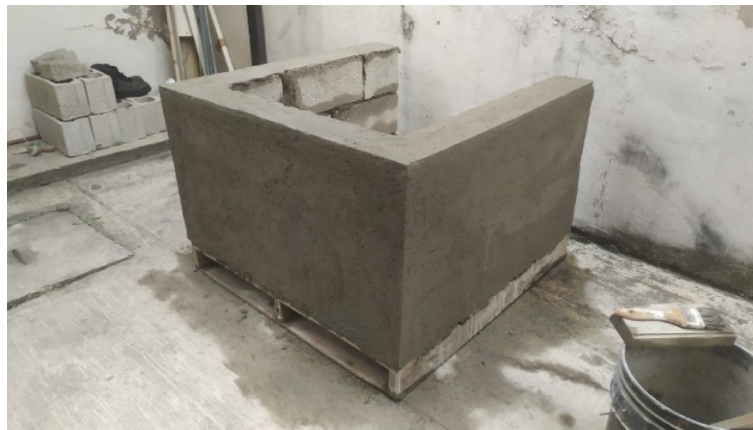
Imagen 20. Infraestructura de muro de pruebas (enlucido)
