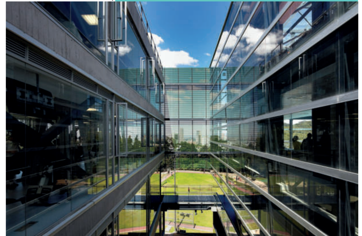
Ilustración 64: Vista exterior 3. Fuente: (MGP, 2009)
