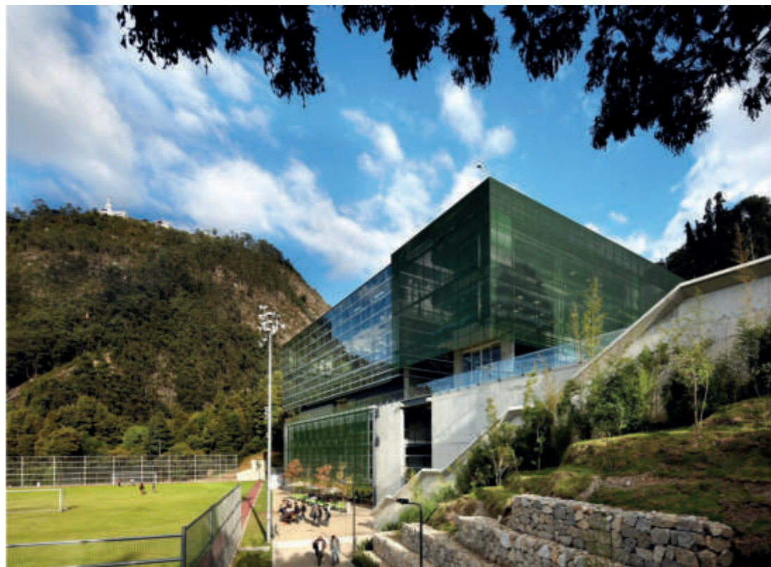
Ilustración 63: Vista exterior 2. Fuente: (MGP, 2009)
