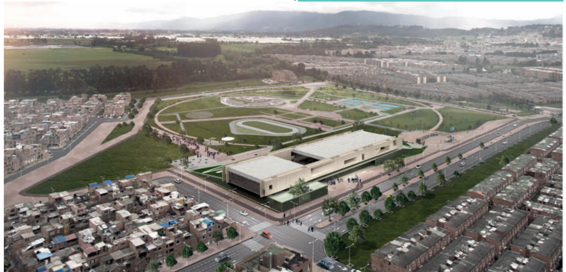
Ilustración 38: Vista exterior del centro deportivo y cultural. Fuente: (Jerez, 2017)
