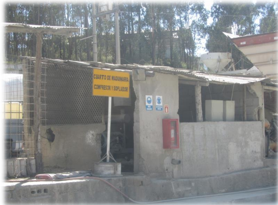
Fotografía 4.8 Cuarto de maquinaria
