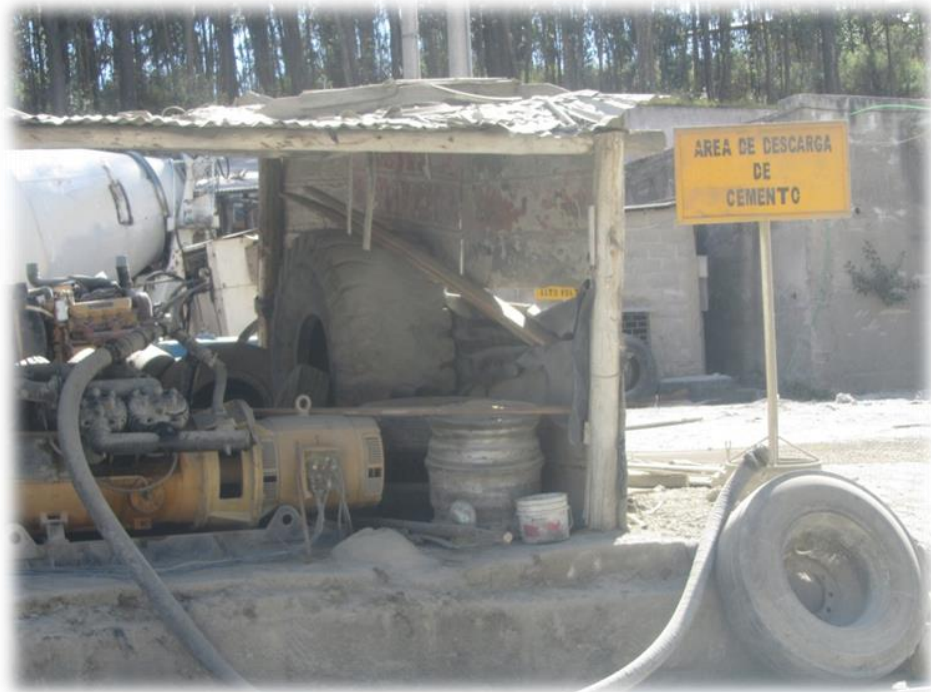
Fotografía 4.9 Area de descarga de cemento
