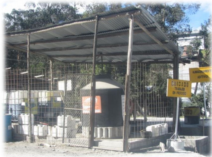
Fotografía 4.7 Area de Almacenamiento de Aditivos
