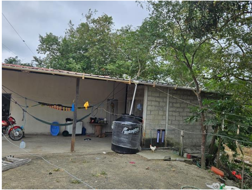
Ilustración 6. Sistema de cosecha y almacenamiento de agua lluvia
