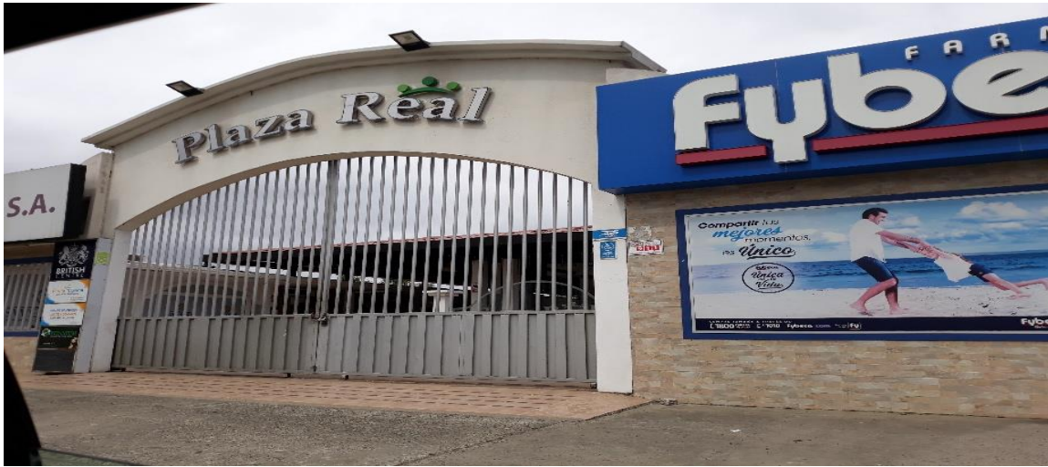
Ilustración 6. Edificación Plaza Real Fuente: Investigación de Campo
