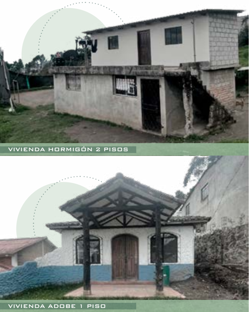
Figura 59. Ejemplo de altura de edificaciones y su materialidad
