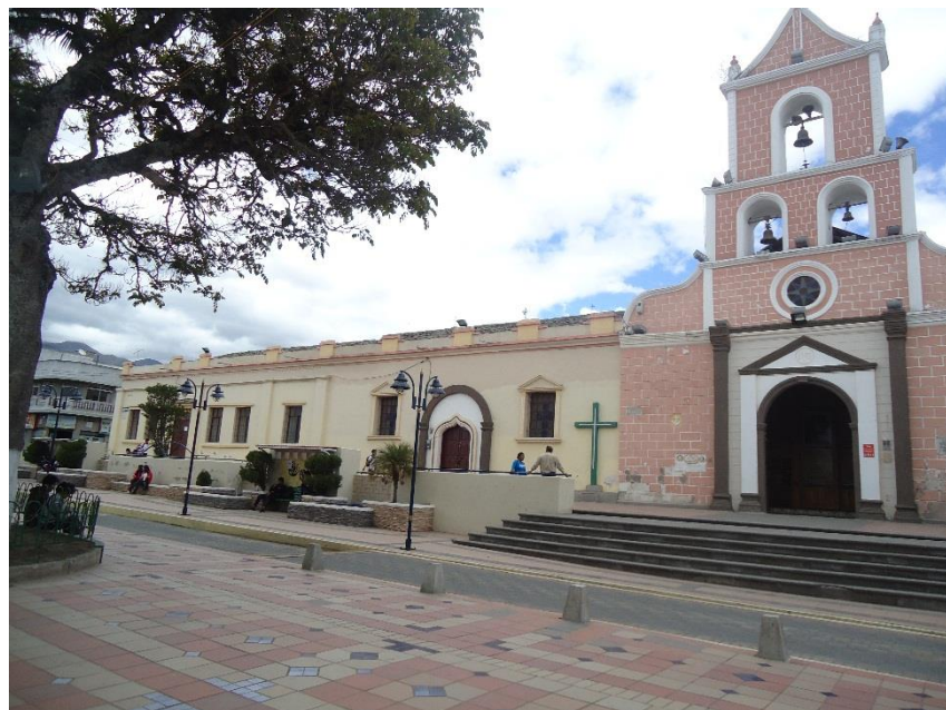
Imagen 109: Tramo de la Iglesia _ Variación de acera (pretil) y calle Fuente: Visita de campo
