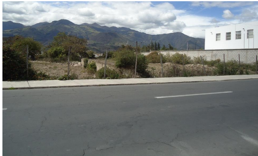
Imagen 101: Vía conectora a la parroquia Tumbabiro – Asfaltada _ norte de la parroquia Urcuquí Fuente: Visita de campo parroquia Urcuquí Realización: Propia G.A.
