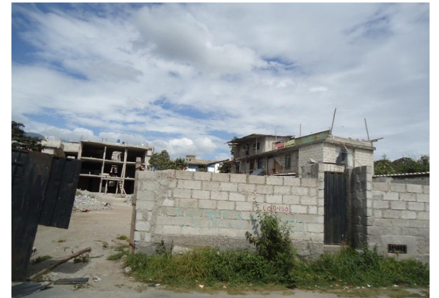
Imagen 73: Hacinamiento de edificaciones. Fuente: Visita de campo parroquia Urcuquí Realización: Propia G.A.
