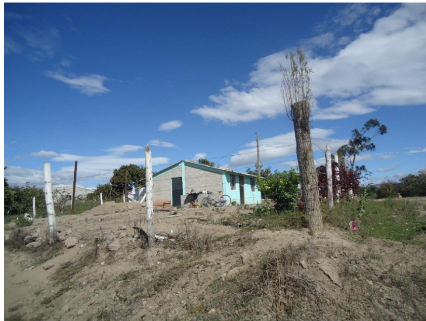
Imagen 71: Falta de control en los cerramientos de los predios Fuente: Visita de campo parroquia Urcuquí
