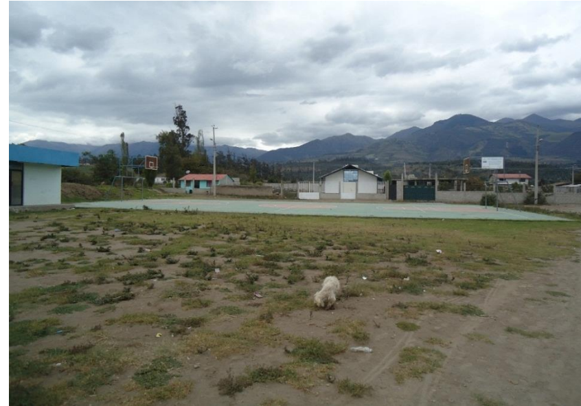
Imagen 78: Equipamiento de recreación mal estado Fuente: Visita de campo parroquia Urcuquí Realización: Propia G.A.
