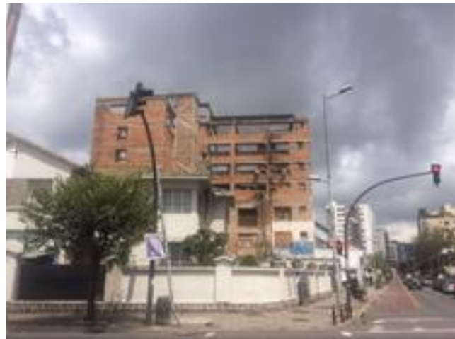
Figura 19. Fotografía edificio incompleto.
