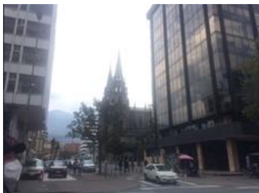
Figura 18. Fotografía de un edificio sin ocupación.
