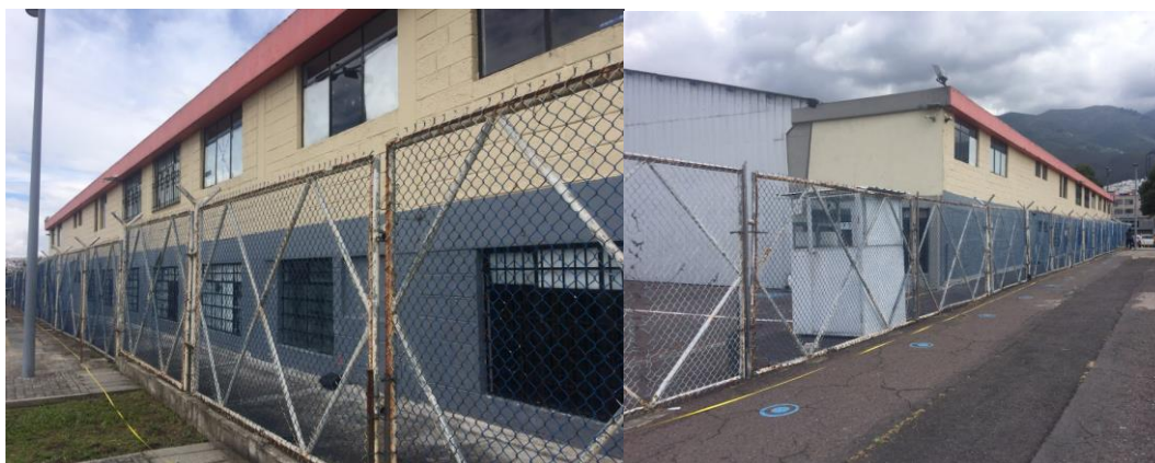
Fuente: Cárdenas M, (2022). Fachada lateral del edificio antiguo de terminal aéreo que colinda con el parqueadero.
