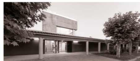
Fachada Principal (Acceso al edificio)
