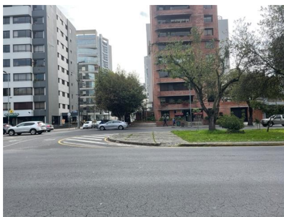
ANEXO 2: Fotografía de la calle Rusia y Av. de los Shyris
