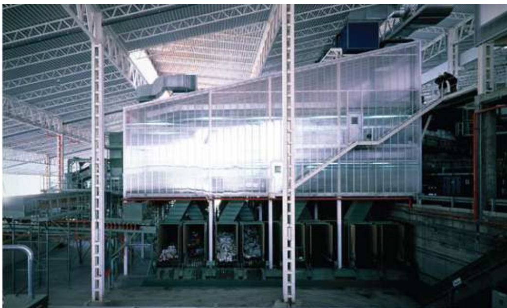
Interior planta de reciclaje
