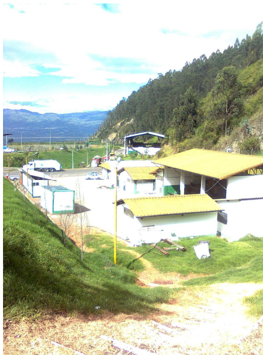
Interior Estación de Transferencia Dos
