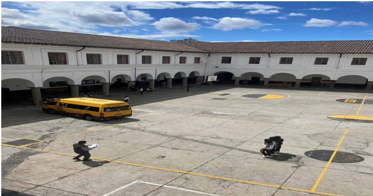
Instalaciones Unidad Educativa San Fernando – Centro Histórico de Quito – Plaza de Santo Domingo – Imagen realizada por el Investigador.
