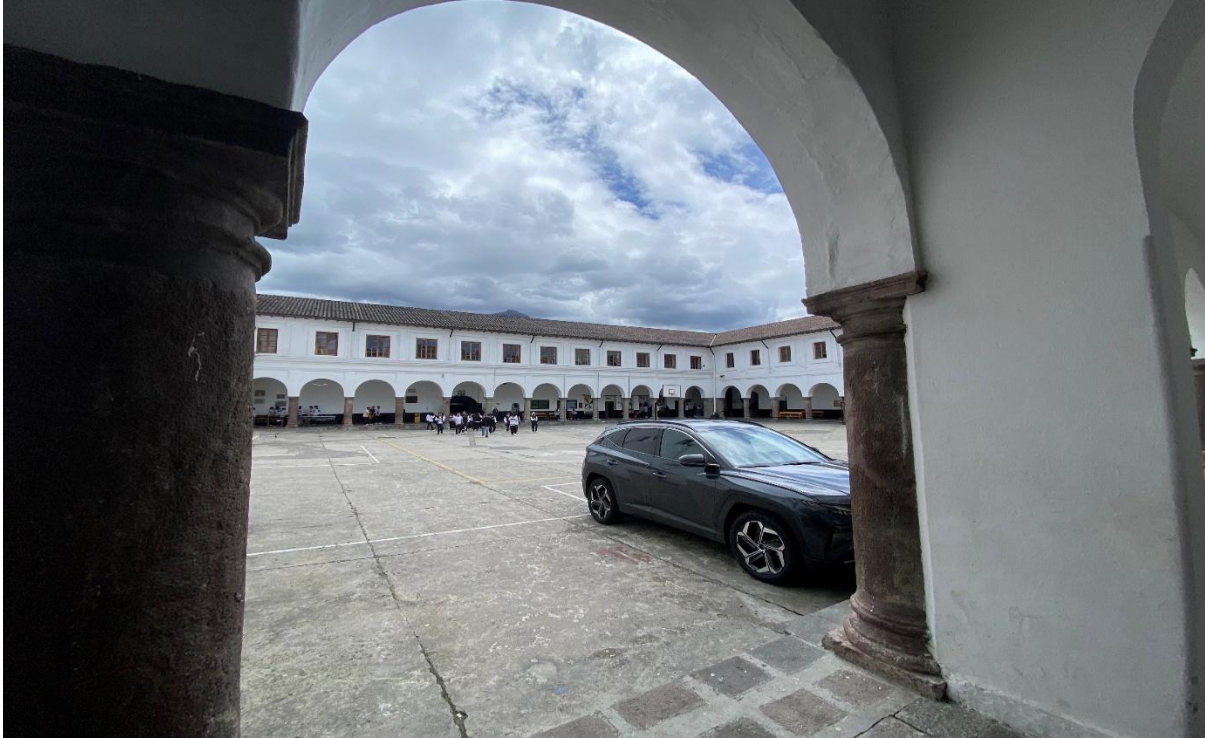
Instalaciones Unidad Educativa San Fernando – Centro Histórico de Quito – Plaza de Santo Domingo – Imagen realizada por el Investigador.
