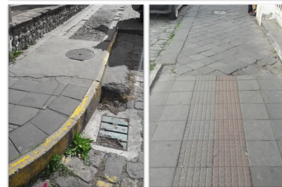
Ilustración 68: Fotografía de varias aceras en el Centro Histórico ciudad de Ibarra Elaboración: Propia (2017)
