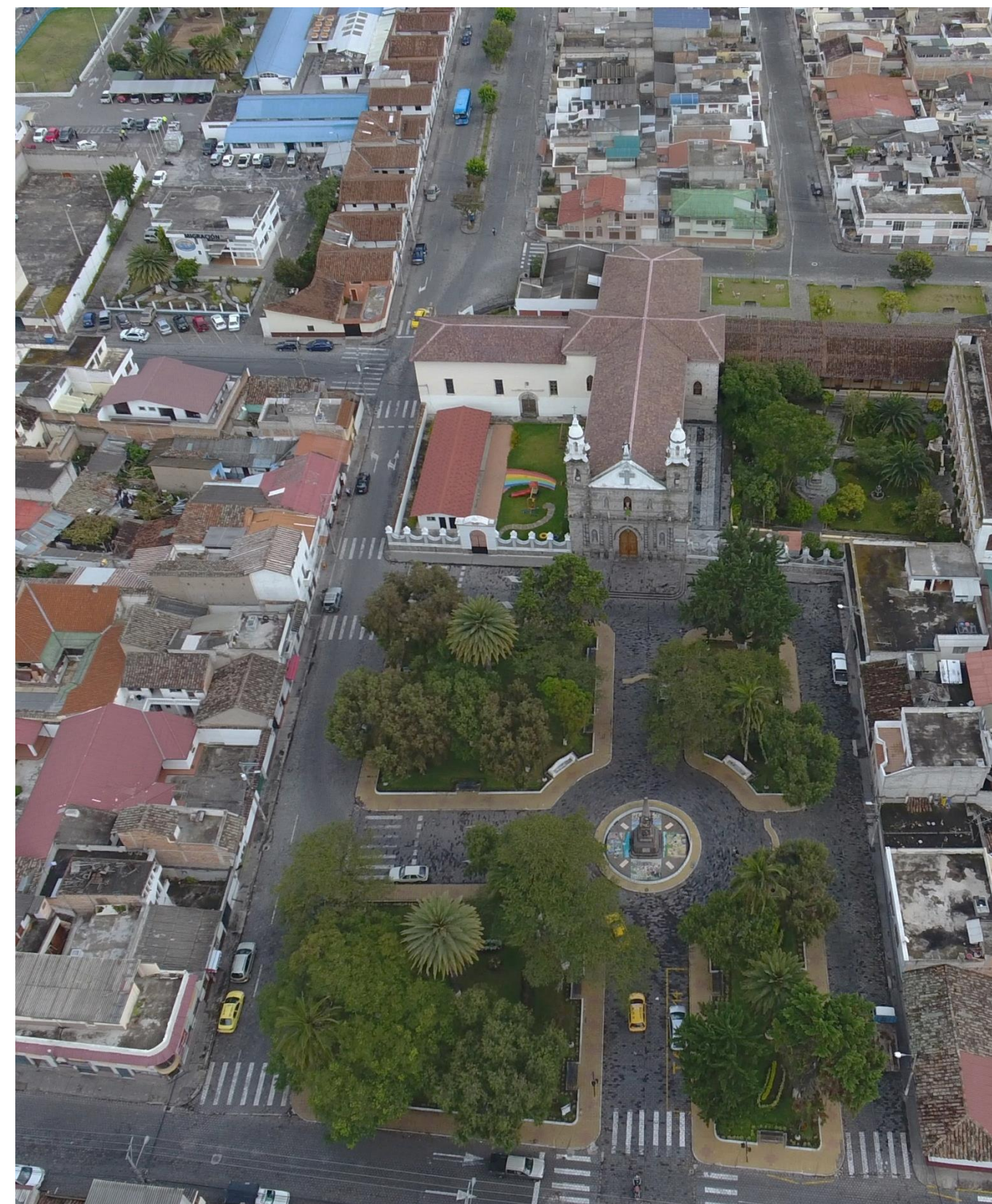
Ilustración 25. Fotografía aérea del espacio público Parque Boyacá Elaboración: propia, 2018
