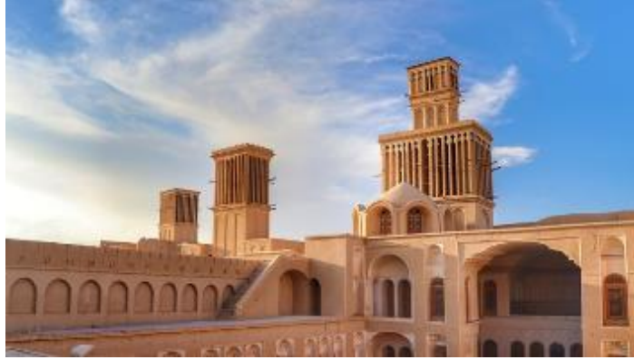
Figura 1. Badgir chimenea de viento utilizado en Irán y Bahreín.
