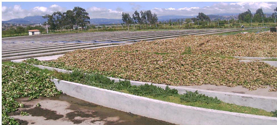
Fotografía 6: Lechos de secado de lodos
