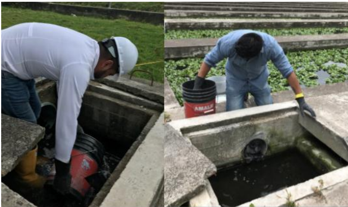
Fotografía 21: Aforo de caudal en la salida de la planta depuradora N°14.
