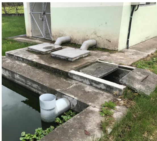
Fotografía 7: Casa de máquinas
