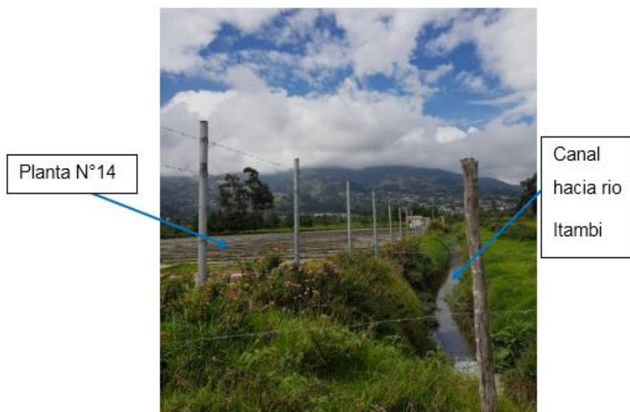
Fotografía 10: Canal receptor del efluente, planta N°14
