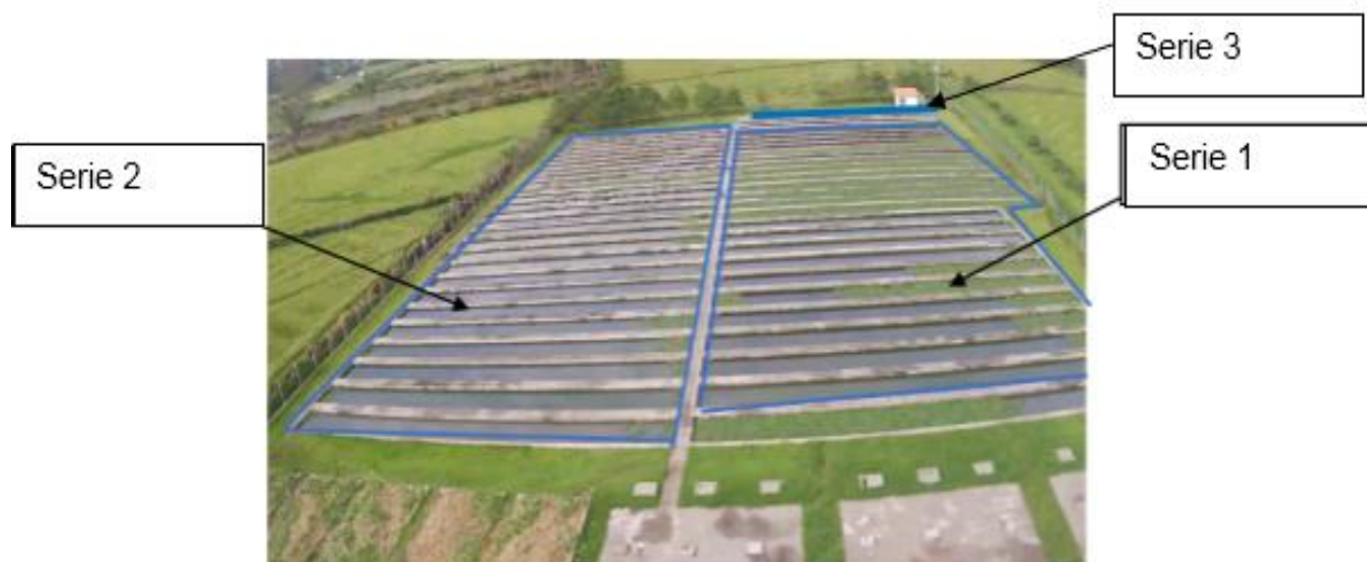
Fotografía 16: Identificación de las tres series en la planta N°14
