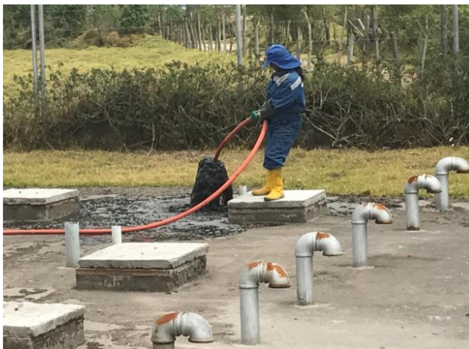
Fotografía 13: Limpieza de filtros percoladores con agua a presión.
