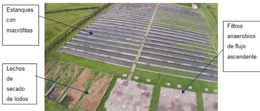
Fotografía 15: Vista aérea de la planta depuradora N°14
