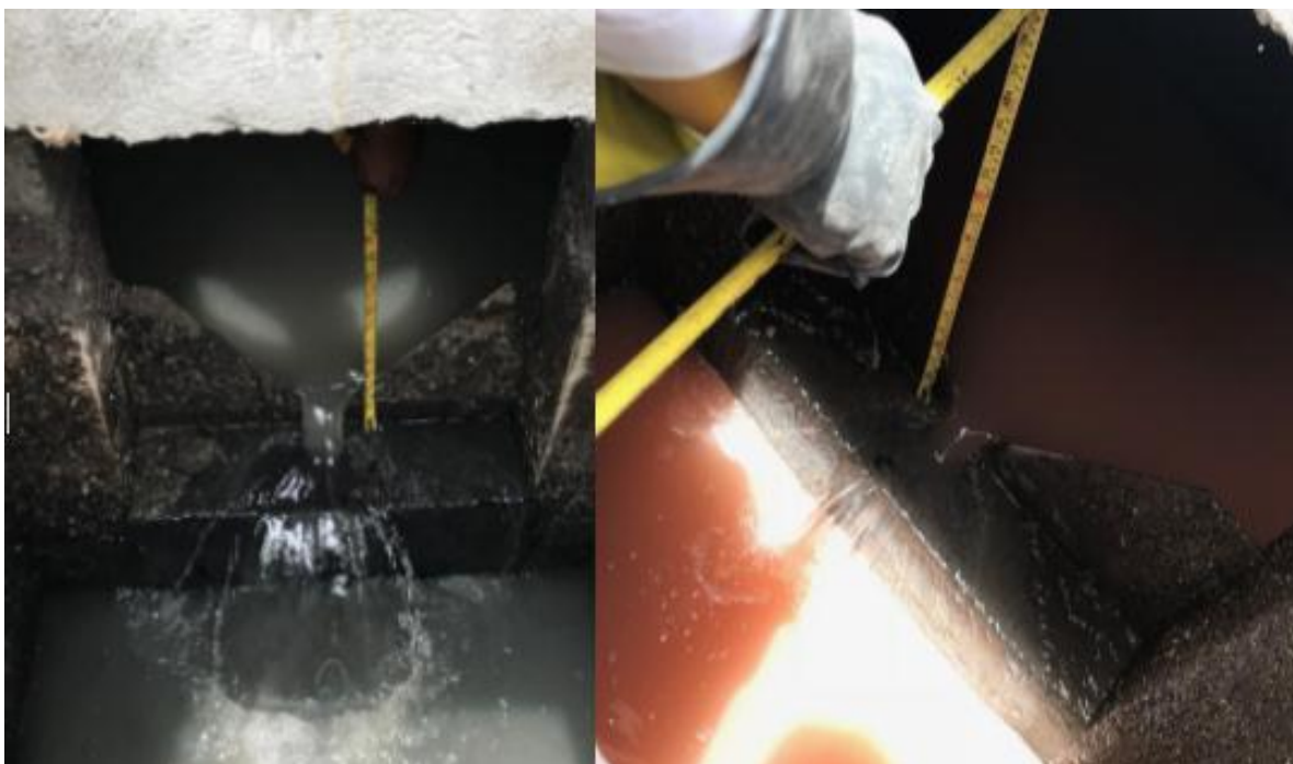
Fotografía 20: Aforo de caudal en la entrada de la planta depuradora N°14.
