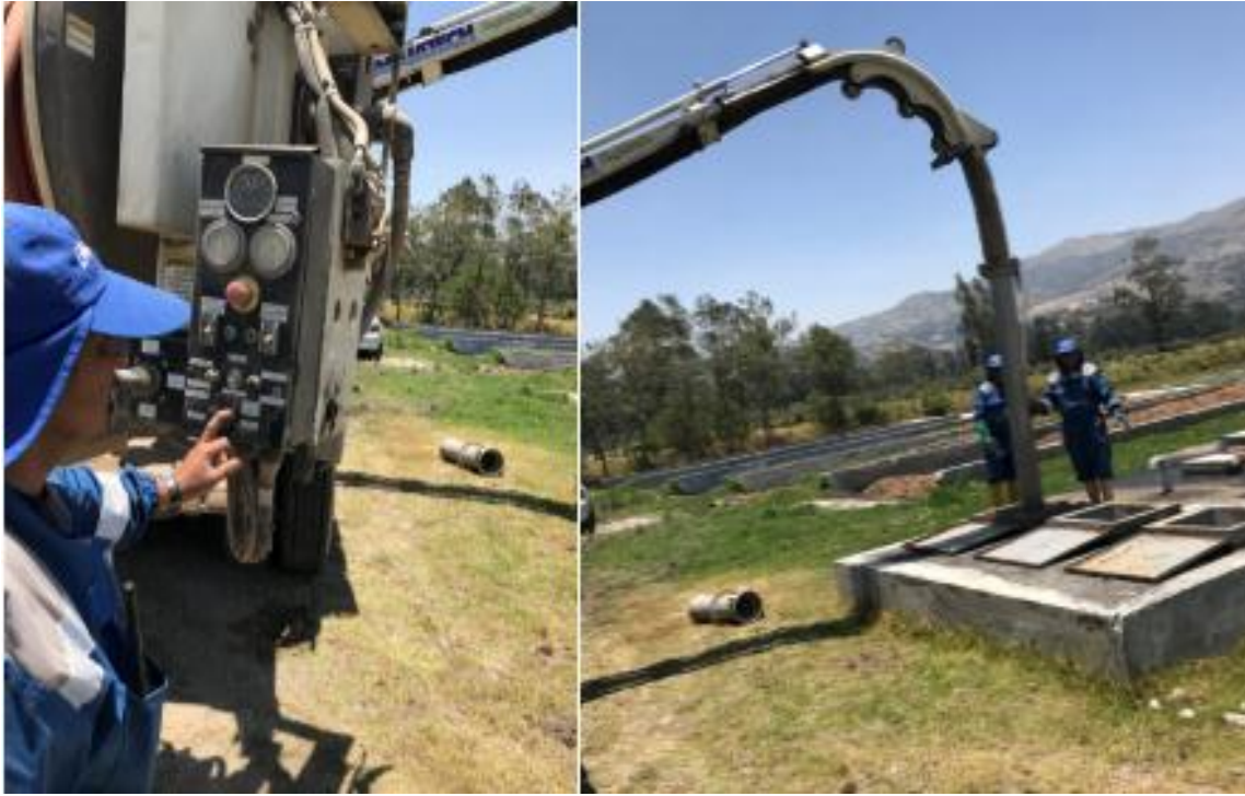
Fotografía 14: Limpieza de separadores de caudal con camión Hidrocleaner.
