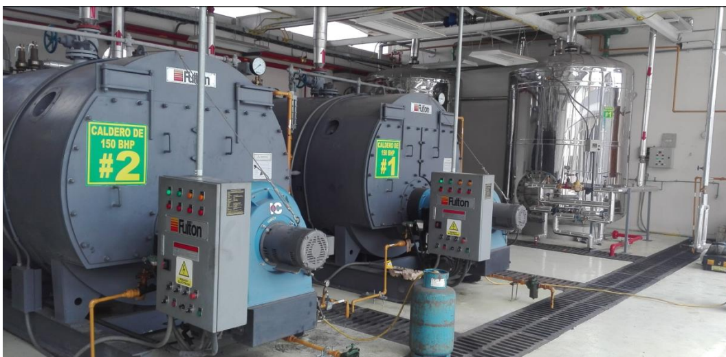
Figura 18: Sistema de Generación de Vapor y Calentamiento de Agua del HGLEA Fuente: Fotografías del
