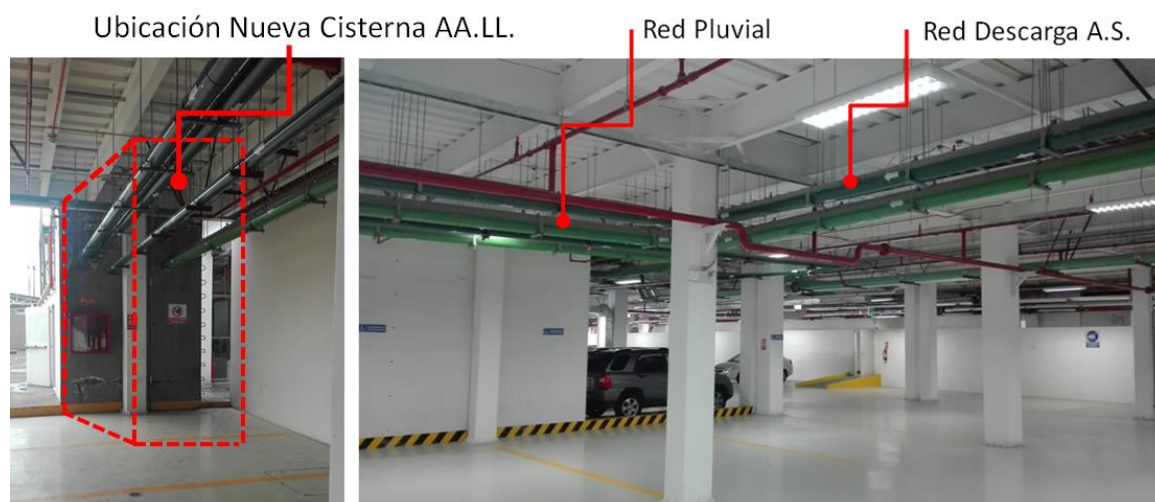
Figura 46: Propuesta para captación de Aguas Lluvias desde la Red Pluvial Existente en el HLEA. Fuente:
