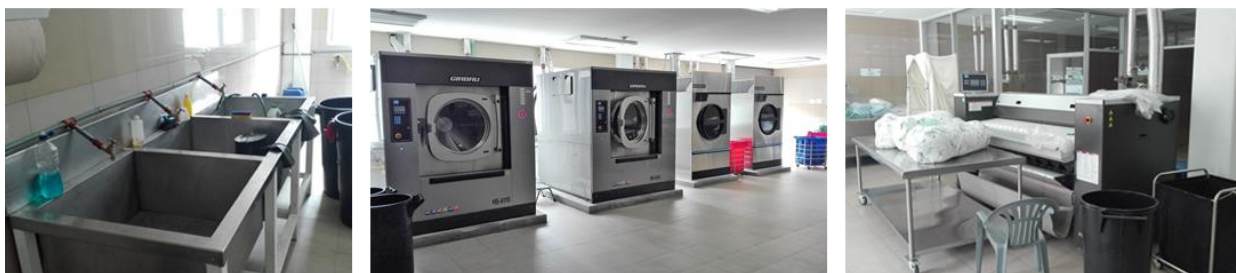
Figura 25: Vista Interior Área de Lavandería Hospital Fuente: Fotografía del Autor.
