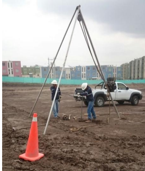
Figura 23. Ensayo SPT en los predios de los Talleres y Cocheras PLMQ.
