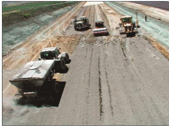
Figura 12. Estabilización con cemento.
