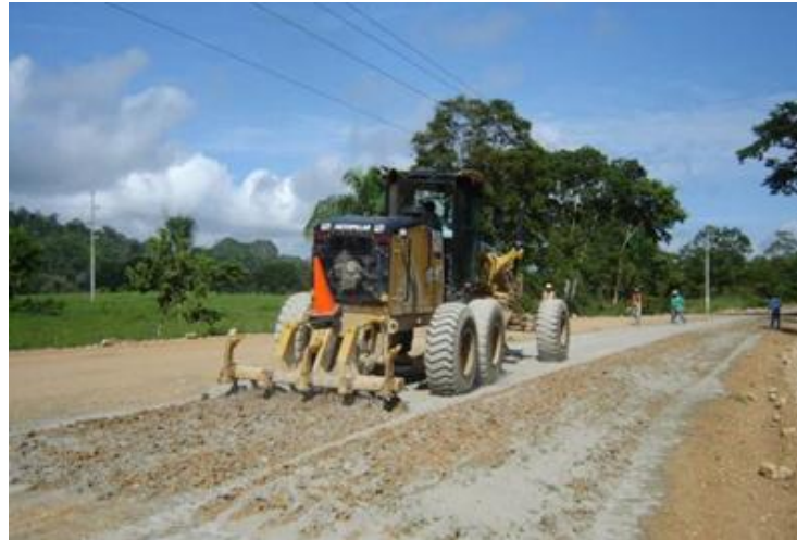
Figura 17. Estabilización Química utilizando cemento.
