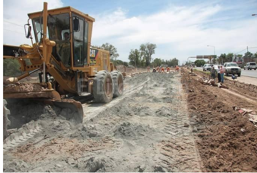
Figura 11. Estabilización de suelo con cemento.
