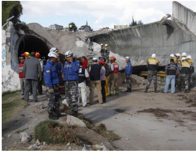
Colapso del paso a desnivel en la avenida Tufiño.
