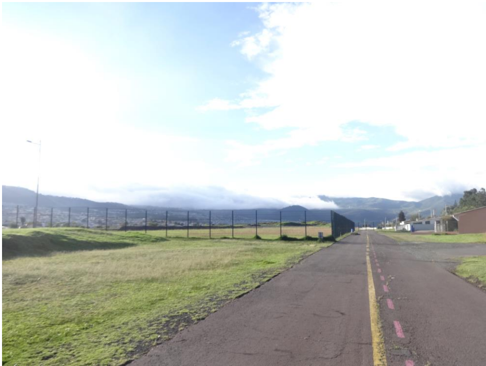
Cerramiento de la cabecera norte del Parque Bicentenario
