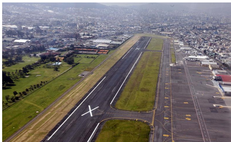
Vista General del Antiguo Aeropuerto Mariscal Sucre
