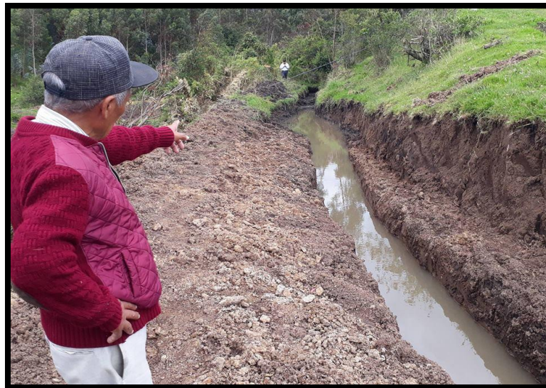
Fotografía 19. Acequia Pisquer Sector San Isidro
