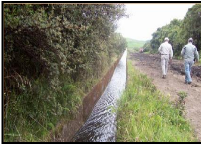
Fotografía 2. Sección canal abierto desde la fuente Río Mal Paso
