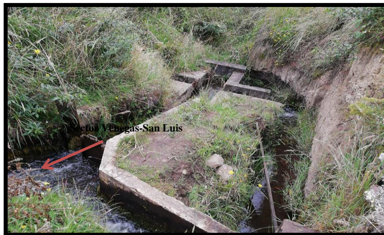
Fotografía 14. Caja de Distribución Principal.
