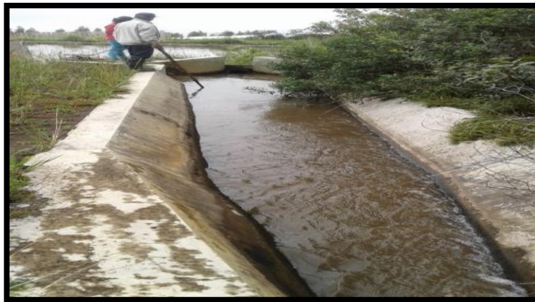
Fotografía 12. Entrada del agua al reservorio
