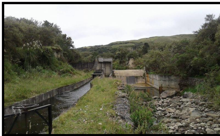
Fotografía 1. Fuente Río Mal Paso, vista aguas abajo
