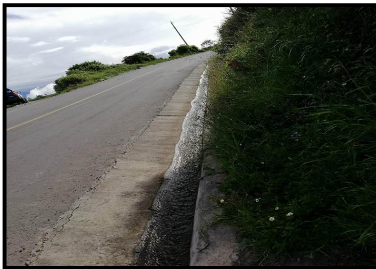
Fotografía 20. Conducción de agua de riego por la cuneta
